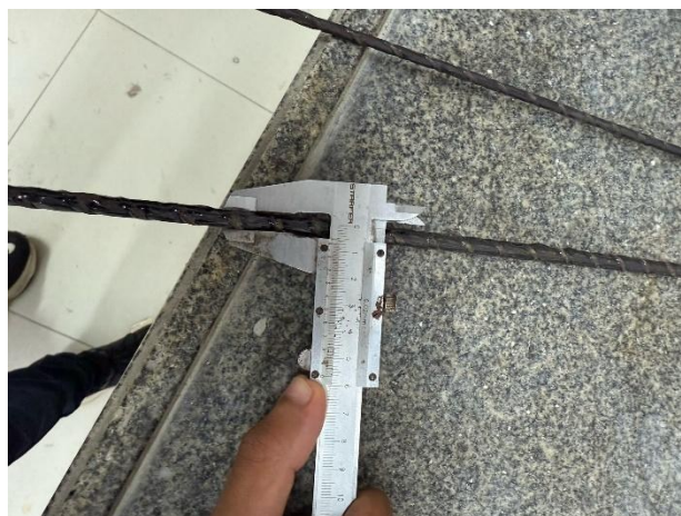
Figura 47: Medição da barra de fibra de vidro a 450 graus
