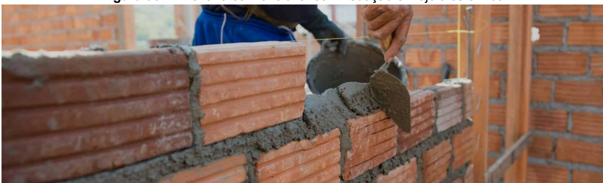
Figura 90 - Alvenaria convencional com vedação em tijolo cerâmico
