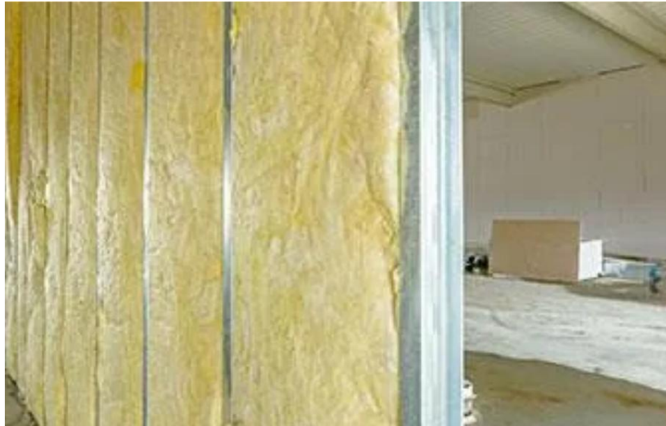
Figura 35 - Representação de estrutura de drywall com aplicação de lã de vidro.
