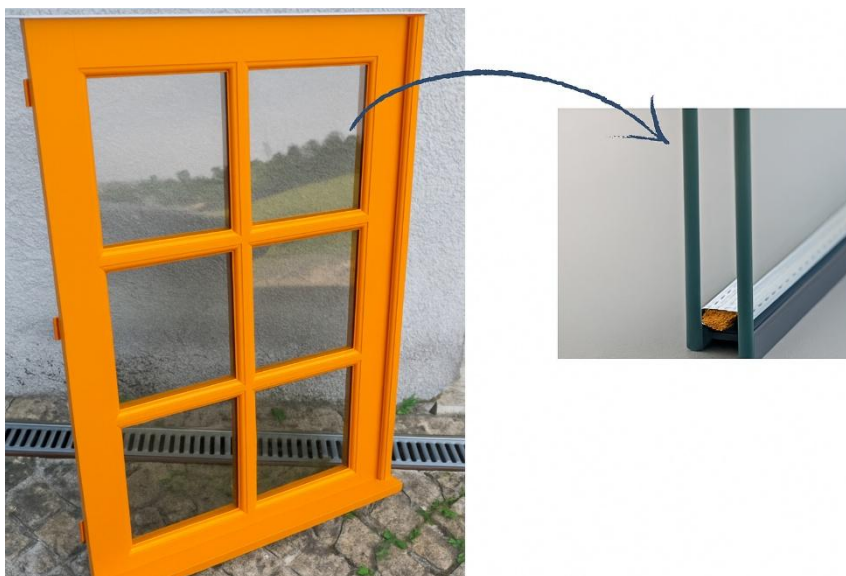
Figura 38 - Representação da janela de madeira com aplicação da lâ de vidro.
