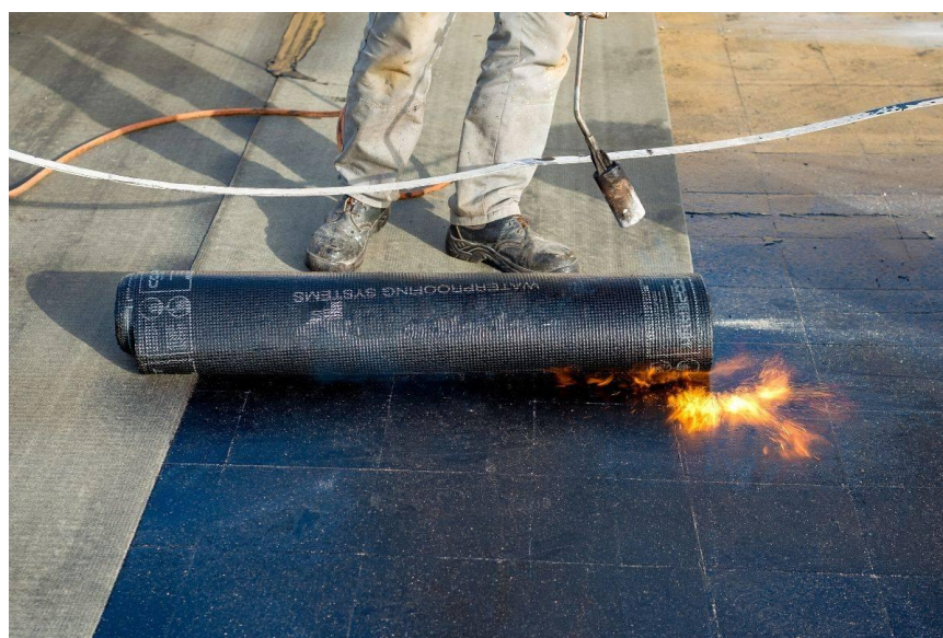
Figura 5 - Aplicação de manta asfáltica em laje de cobertura.
