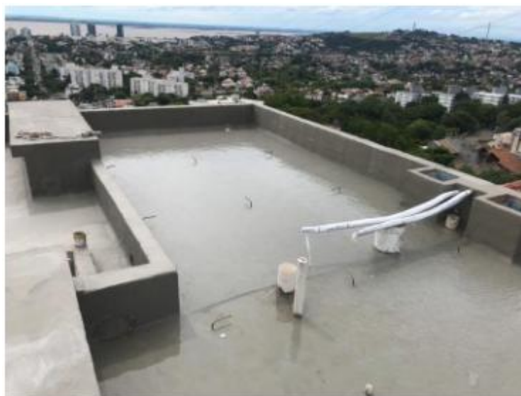
Figura 12 - Teste de estanqueidade em laje de cobertura.
