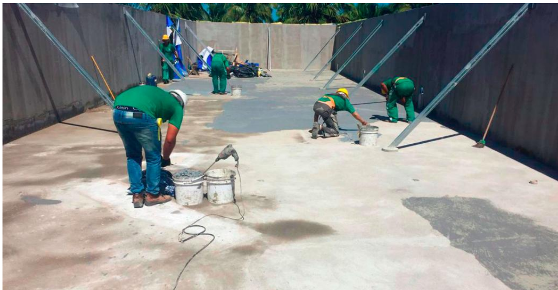
Figura 11 - Aplicação de impermeabilizante polimérico termoplástico.
