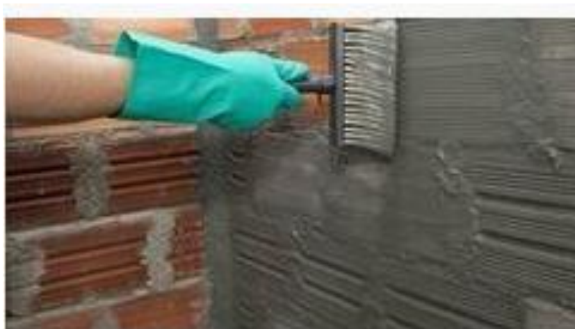
Figura 8 - Aplicação de argamassa polimérica em alvenaria.
