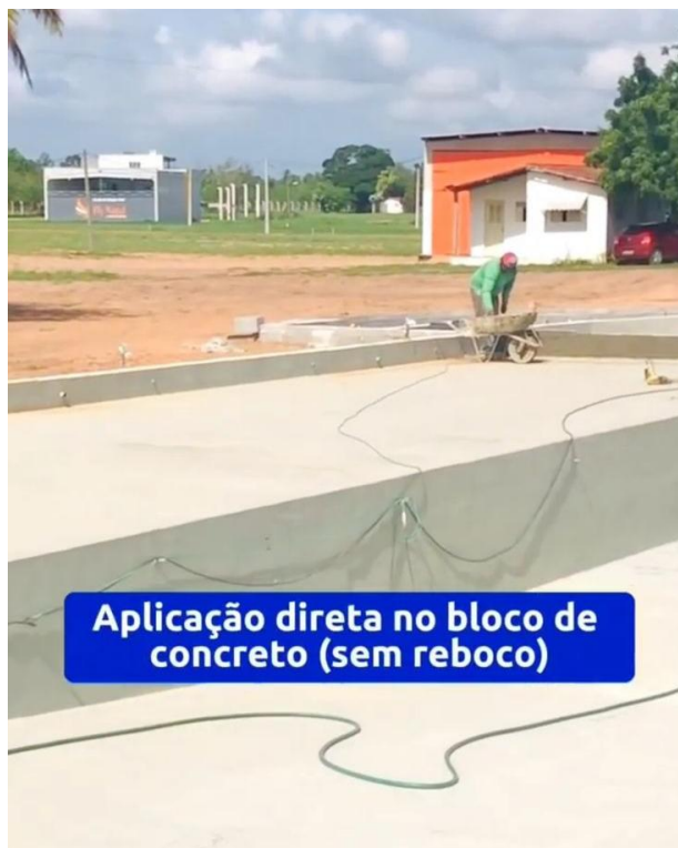
Figura 26 - Aplicação de produto impermeabilizante em piscina.
