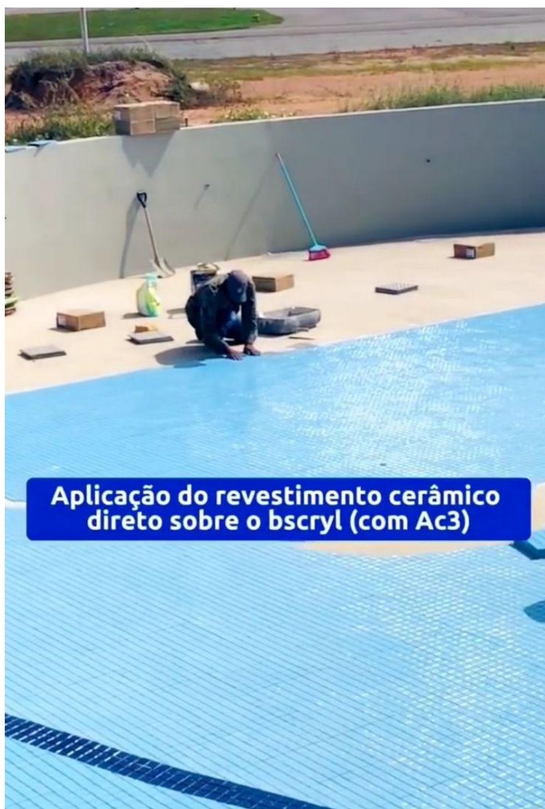
Figura 28 - Aplicação de revestimento cerâmico em piscina.
