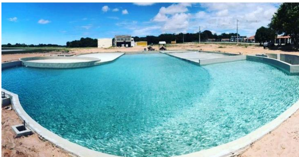
Figura 27 - Teste de estanqueidade em piscina.
