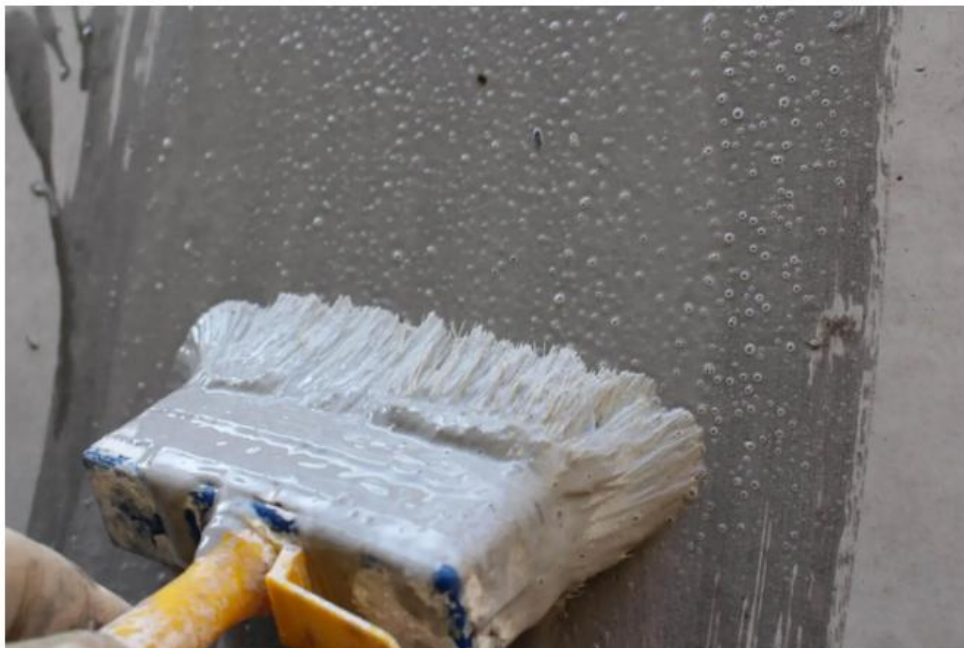
Figura 18 - Formação de bolhas e falhas de aderência por aplicação incorreta.
