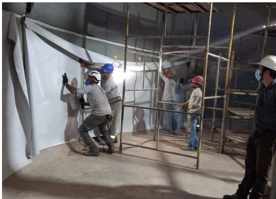
Figura 6 - Instalação de manta de PVC em reservatório.
