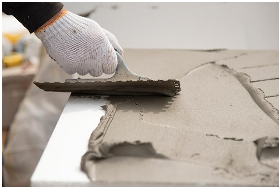
Figura 15: Aplicação manual de argamassa polimérica impermeabilizante.
