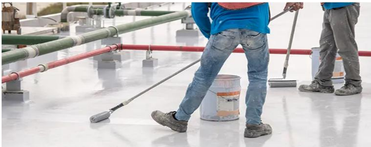
Figura 7 - Aplicação de membrana acrílica líquida.
