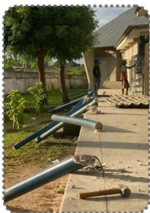
DEMOLIÇÃO DAS COBERTURAS DAS CIRCULAÇÕES
