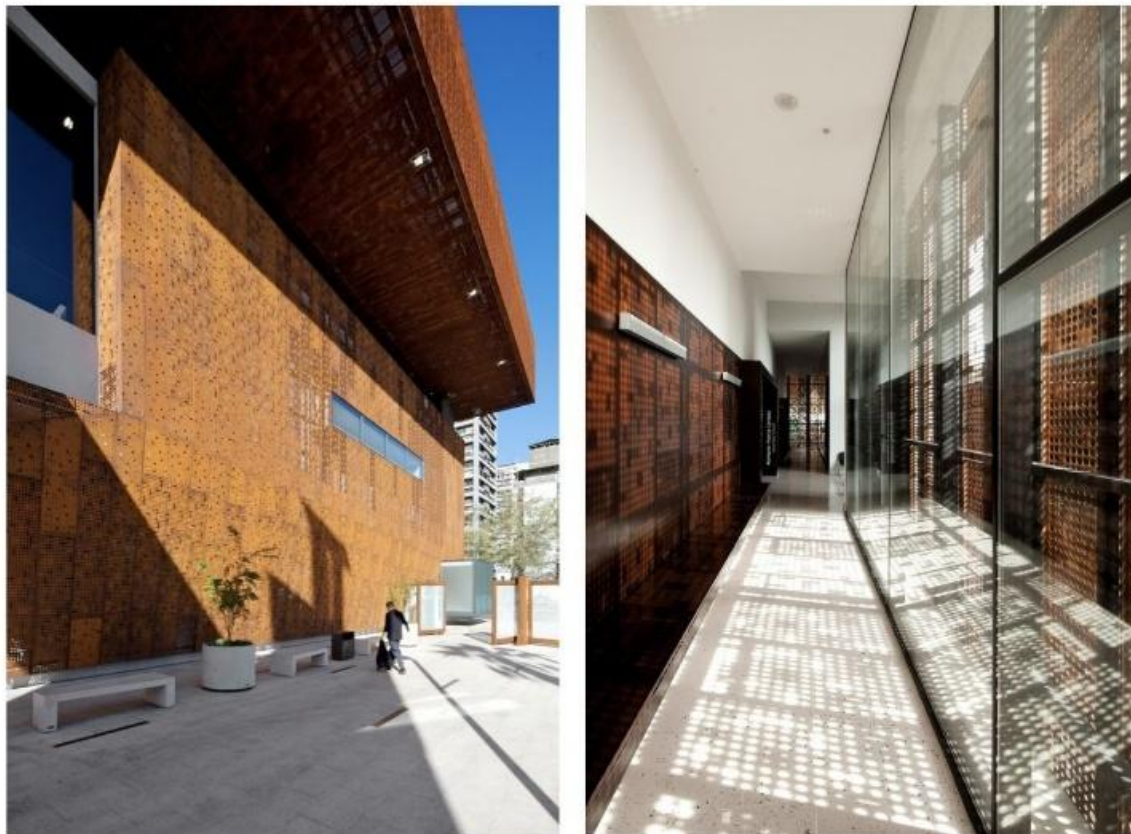
Figura 24 - contribuição dos painéis para a insolação
