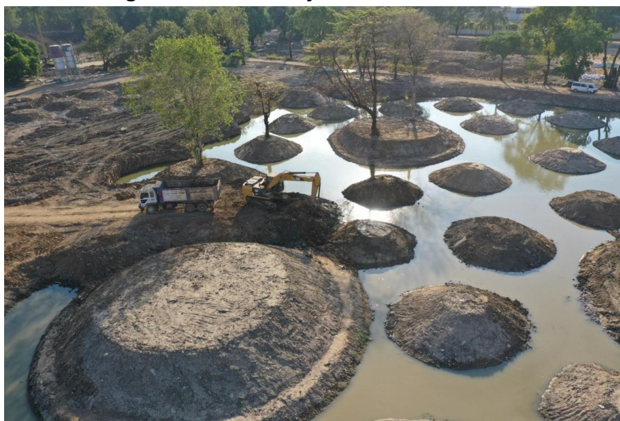
Figura 62 – Construção das Ilhas Artificiais
