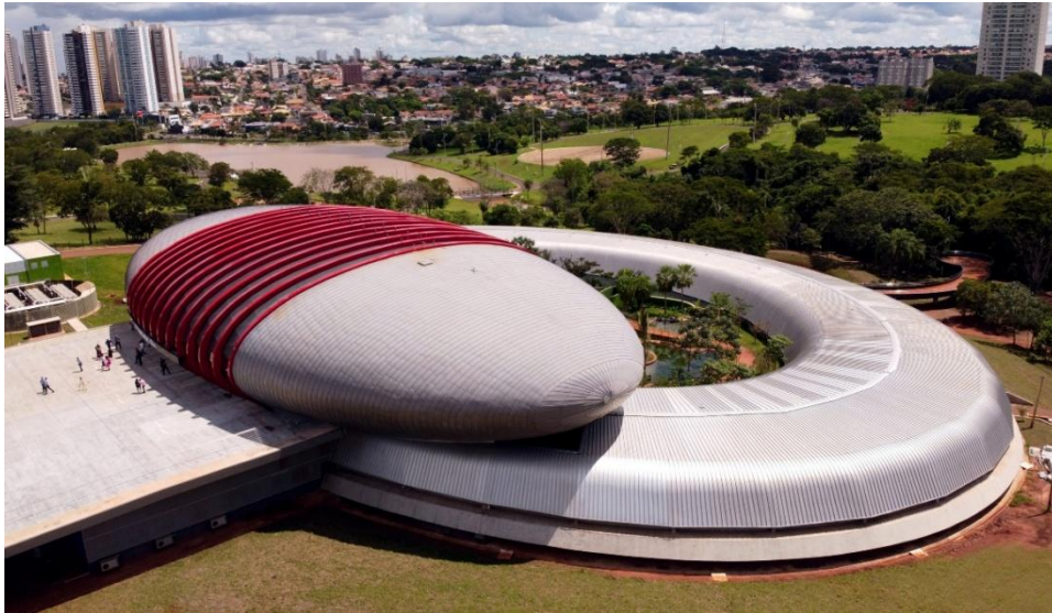
Figura 14: Estrutura externa do Aquário do Pantanal
