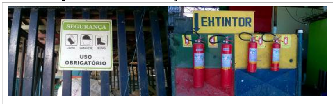
Figura 5 – Placas de sinalização dos locais de armazenamento
