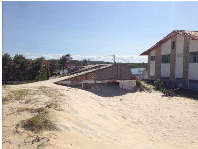
Fotografia 9 – Residência soterrada por dunas na praia de Jenipabu.
