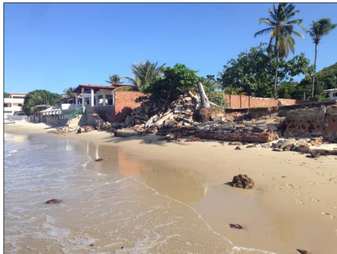
Fotografia 3 – Erosão costeira na praia de Santa Rita, APAJ – Extremoz/RN.
