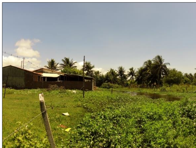
Fotografia 5 – Residência construída no limite de cheia regular do Rio Doce.
