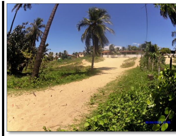
Fotografia 1 – Ocupações em Santa Rita em áreas de declive sujeitas ao deslizamento de solo
