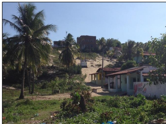
Fotografia 2 – Ocupações com mais de 1 pavimento sujeitas ao deslizamento de solo.
