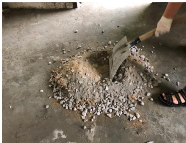
Figura 20 – Execução do traço da mistura de concreto fibroso.
