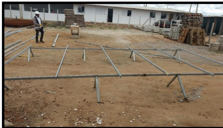
Figura 23 - Montagem dos banzos no gabarito
