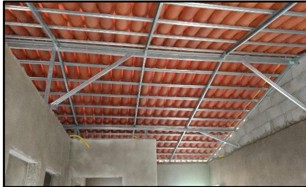
Figura 3 - Estrutura metálica com telha cerâmica
