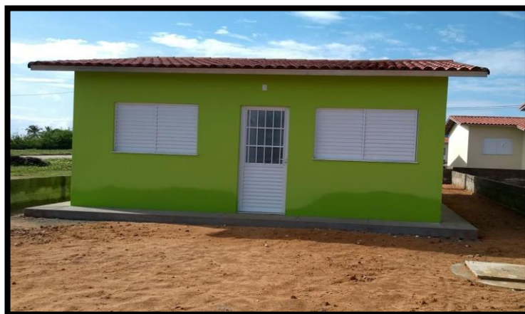
Figura 28 - Fachada, empreendimento concluído
