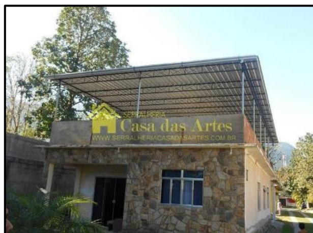
Figura 2 - Cobertura metálica residencial com telha metálica
