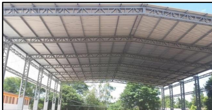
Figura 1 – Cobertura metálica em galpão
