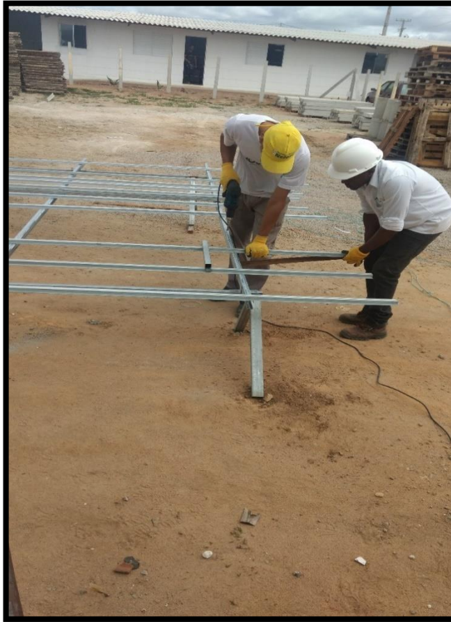
Figura 24 - Processo de fixação dos elementos de ripa nos banzos
