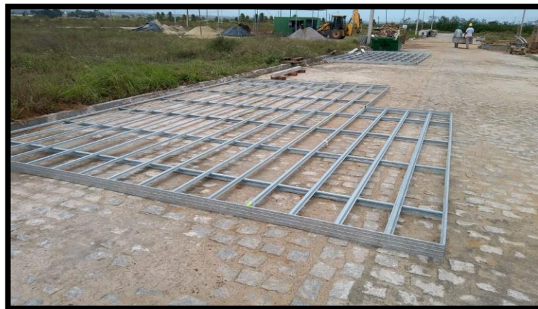
Figura 26 - Painéis ripados prontos para serem erguidos
