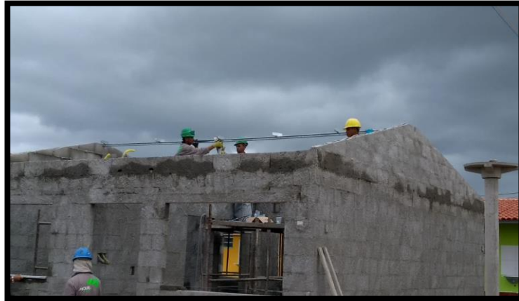
Figura 18 - Colocação das linhas estruturais
