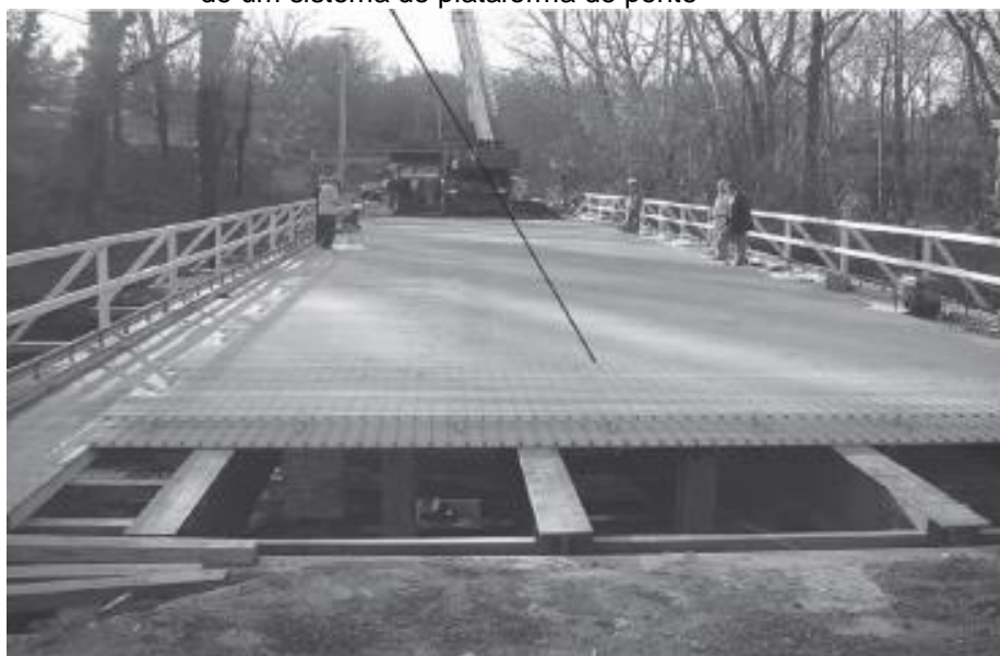
Figura 10 - Secções pultrudadas de éster vinílico reforçado com fibra de vidro na construção de um sistema de plataforma de ponte
