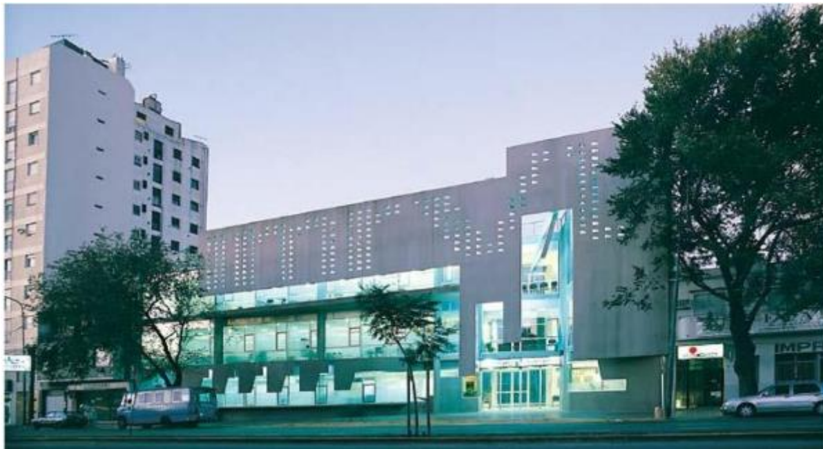
Figura 34- Fachada do Instituto Vicente Lopes.
