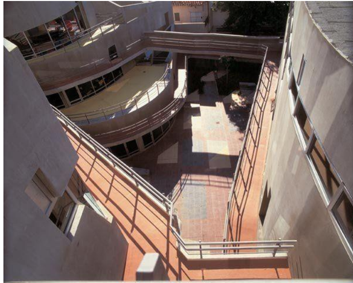
Figura 35- Sistema de rampas do Instituto Vicente Lopes.
