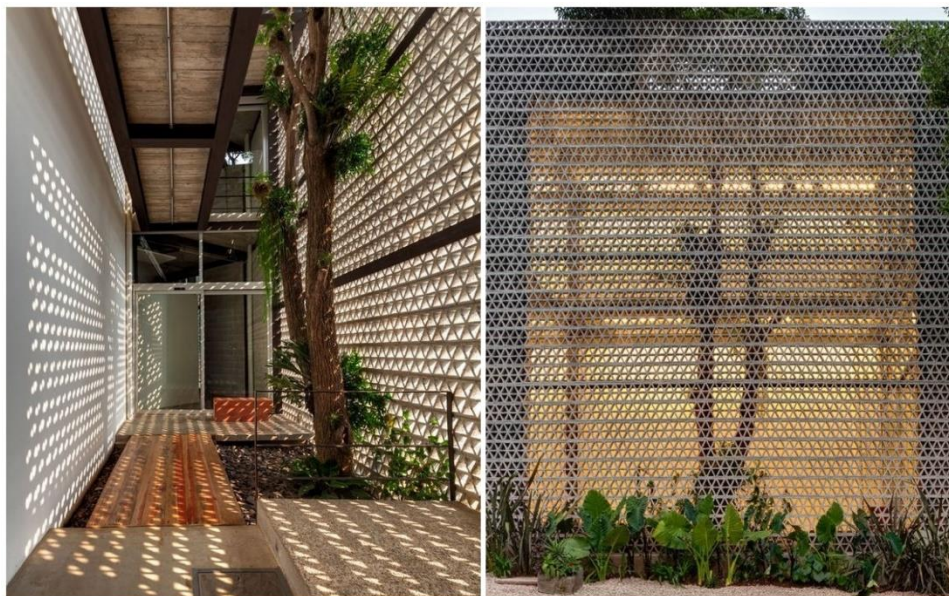
Figura 11- Utilização de cobogós para proporcionar iluminação natural.
