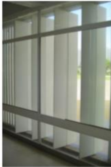
Figura 33- Brises-soleils da fachada do Hospital Sarah, Rio de Janeiro.
