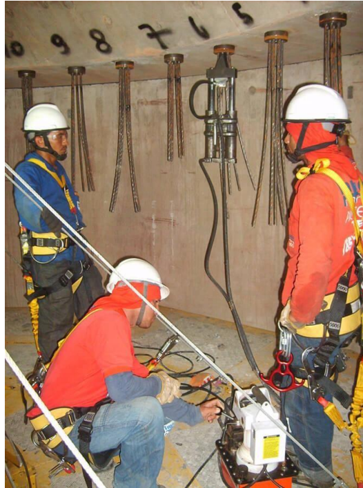
Figura 19 - Protensão nas cordoalhas das torres eólicas
