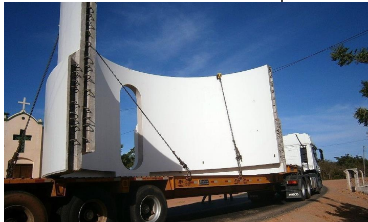
Figura 23 - Base de uma torre de concreto pré-moldada
