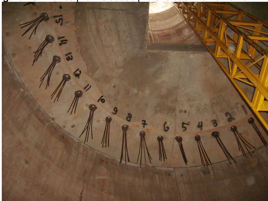
Figura 18 - Torres pré moldadas protendidas internamente
