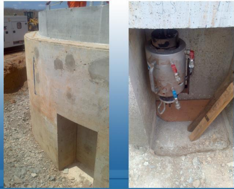
Figura 20 - Protensão externa
