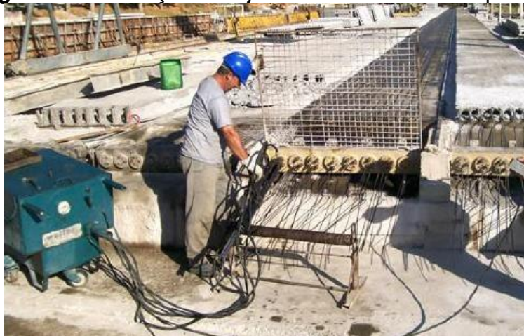
Figura 6 - Confeccção da laje alveolar em concreto protendido
