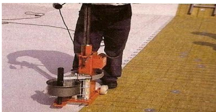
Figura 17 – Fixação automática com parafusos e arruelas especiais.
