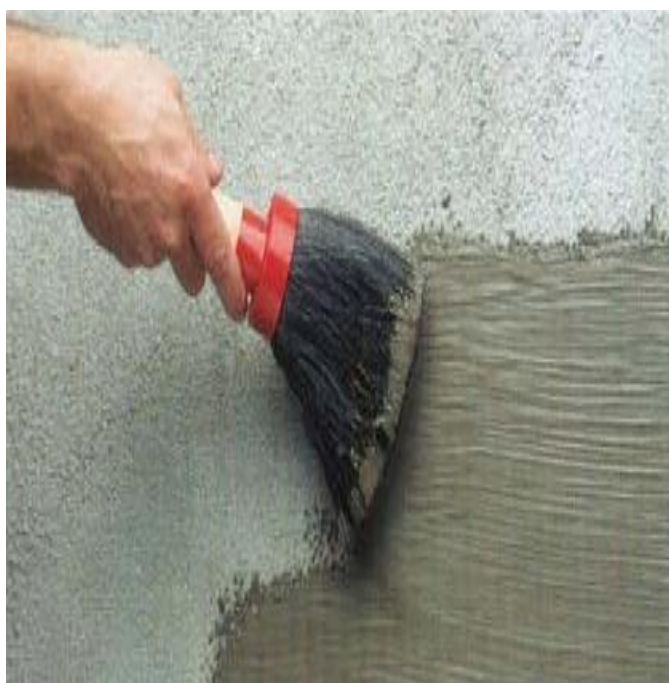
Figura 7 – Aplicação de argamassa polimérica na forma de pintura.
