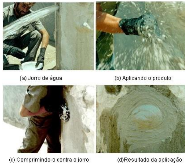
Figura 6 – Cimento impermeabilizante de pega ultra-rápida.
