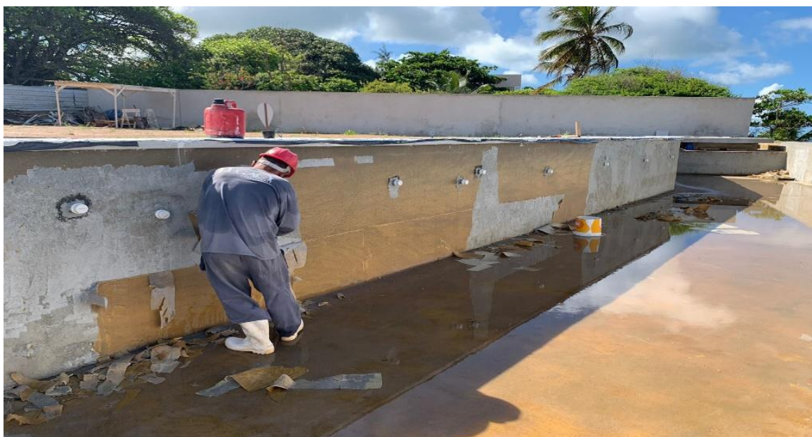
Figura 31 - Remoção do Poliuretano Vegetal.
