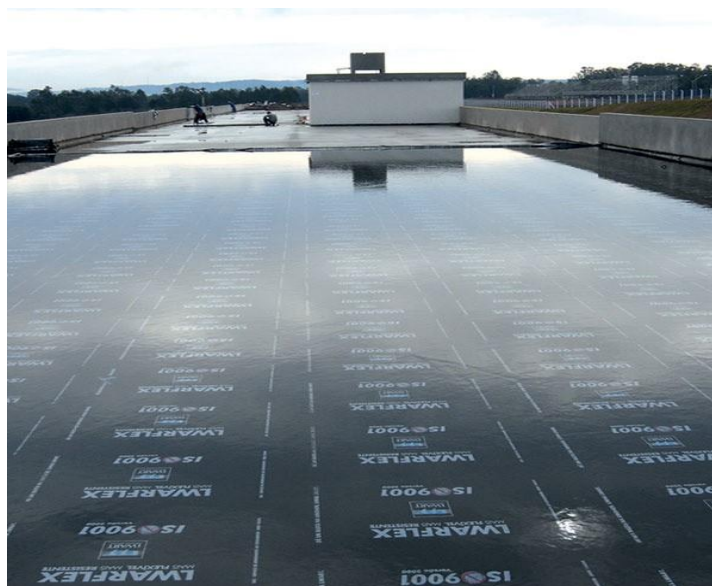
Figura 14 – Teste de estanqueidade.
