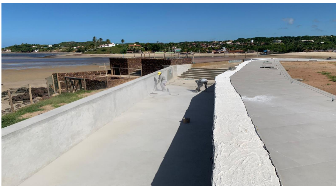
Figura 32 - Lixamento da parede para remover resquícios do Poliuretano.
