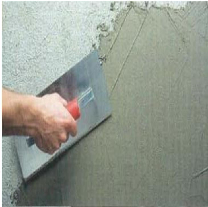
Figura 8 – Aplicação de argamassa polimérica na forma de revestimento.
