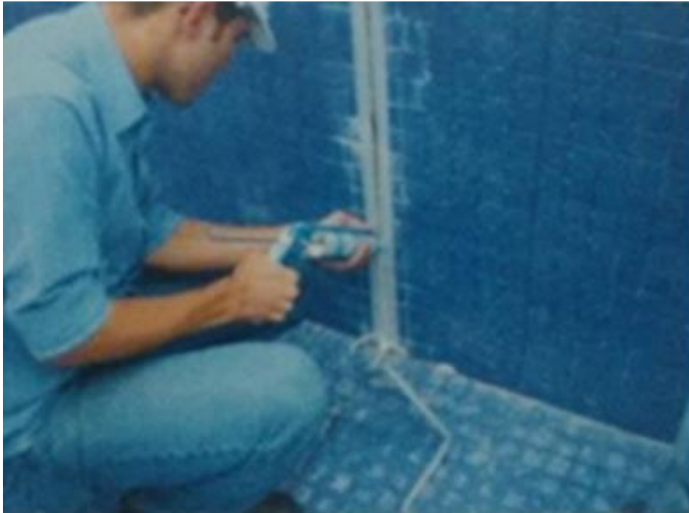
Figura 27 - Aplicação do Selante.
