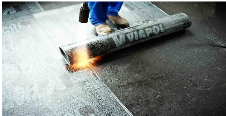
Figura 13 – Execução de manta asfáltica com maçarico.
