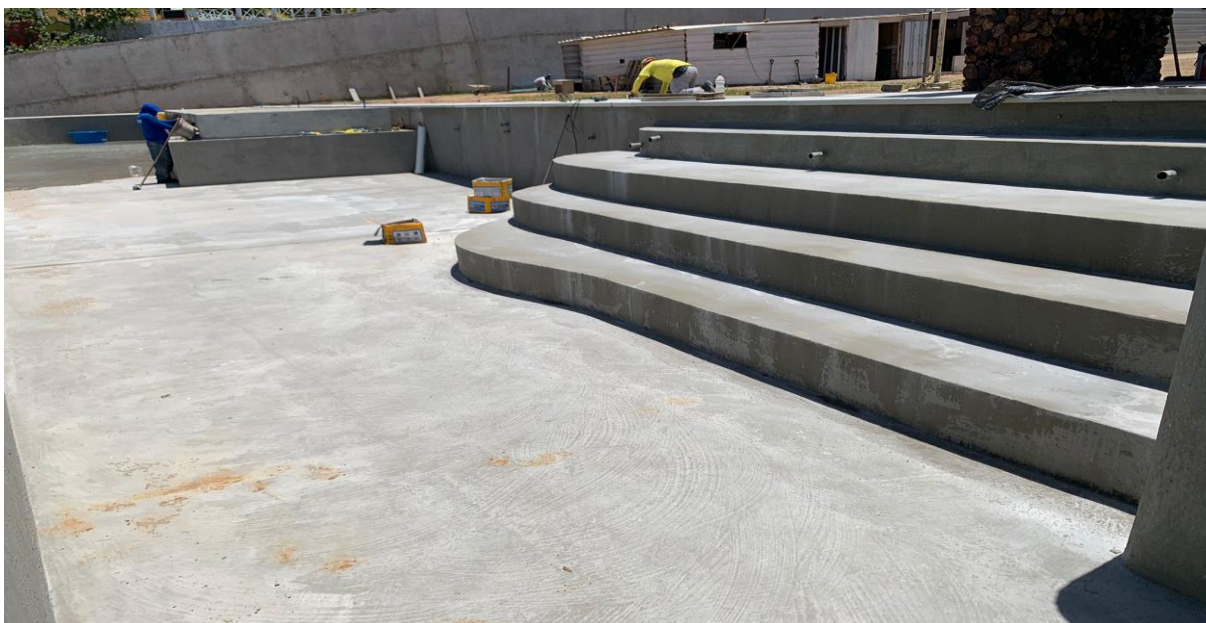
Figura 34 - Limpeza para aplicação do material impermeabilizante.
