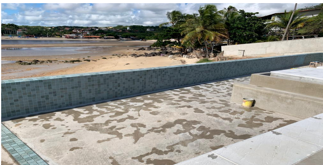
Figura 36 - Aplicação do revestimento cerâmico.
