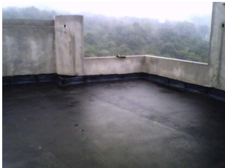
Figura 12 – Imprimação da superfície.
