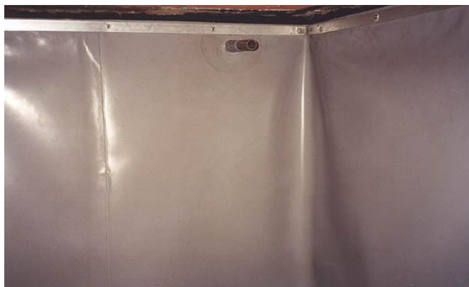
Figura 18 – Fixação com perfis tipo cantoneira em reservatório.
