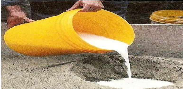
Figura 3 – Preparação da argamassa com o aditivo hidrófugo.
