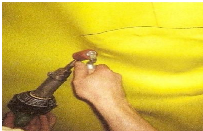
Figura 16 – Processo de solda com equipamento manual.
