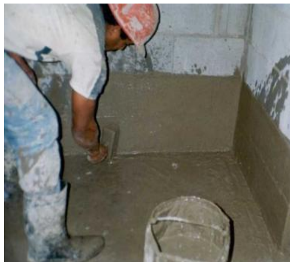
Figura 11 – Execução de membrana acrílica.
