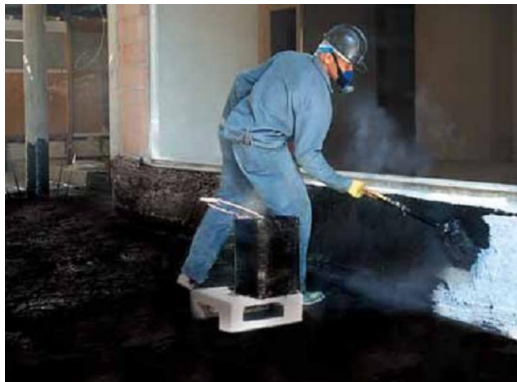
Figura 10 – Execução de membrana de asfalto a quente.
