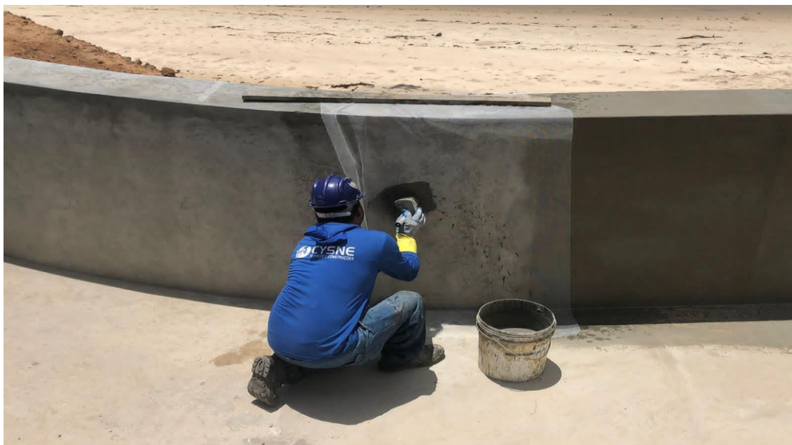
Figura 33 - Aplicação da argamassa polimérica.
