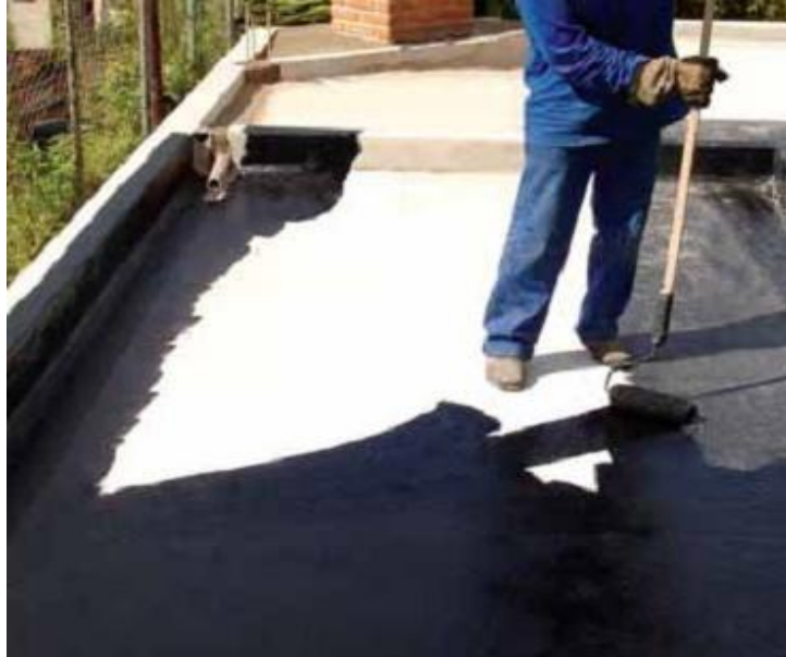
Figura 9 – Execução de membrana de asfalto a frio.
