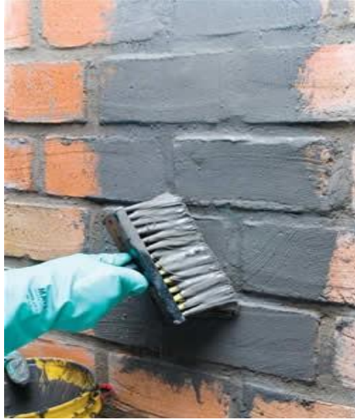
Figura 4 – Aplicação de cristalizante na forma de pintura
