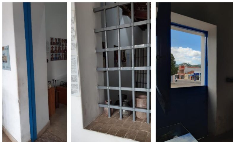
Figura 7 - Imagens das espessuras das paredes.
