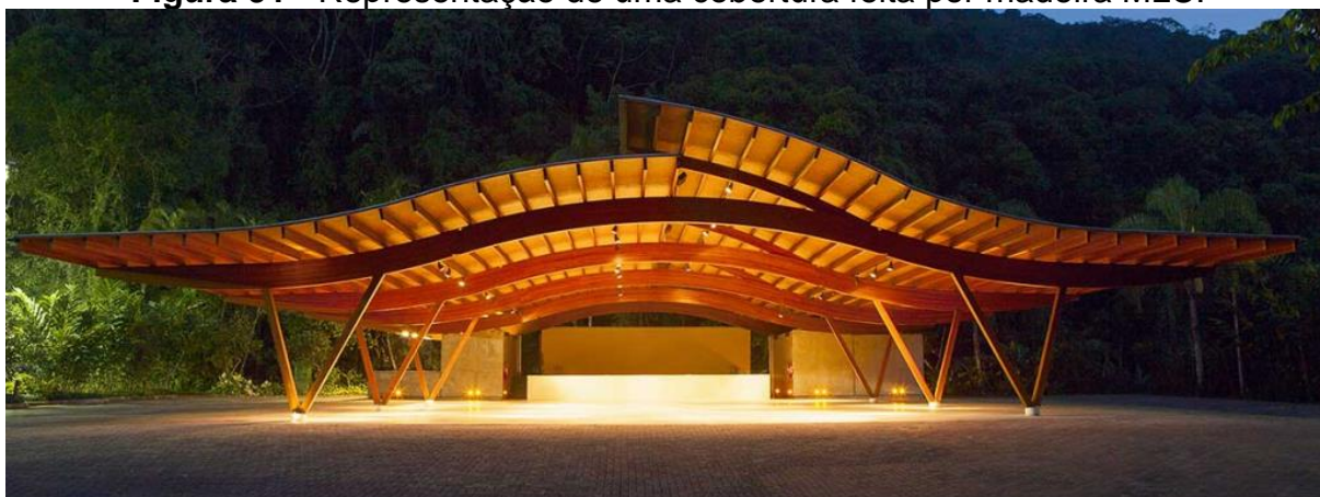
Figura 91 - Representação de uma cobertura feita por madeira MLC.
