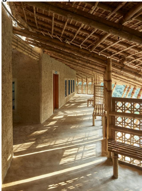
Figura 17 - Vista da parte interna do centro.
