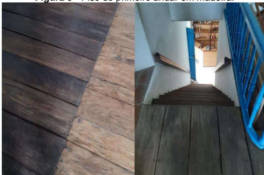
Figura 9 - Piso do primeiro andar em madeira.
