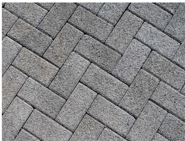
Figura 60 – Piso drenante paver.
