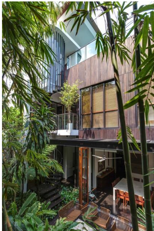
Figura 30 - Fachada interna da residência Merryn Road 40ª, Singapura.
