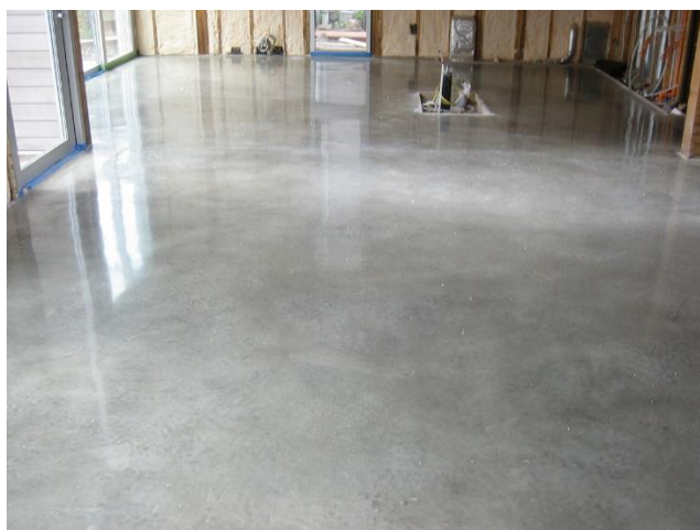
Figura 61 – Piso em concreto alisado.
