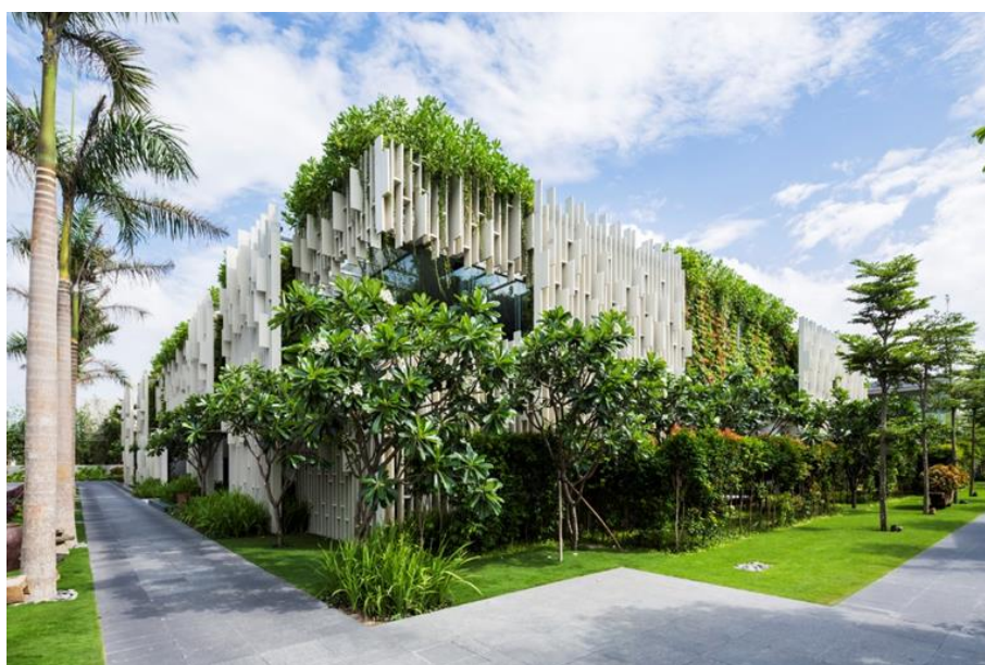
Figura 25 – Fachada do Spa.
