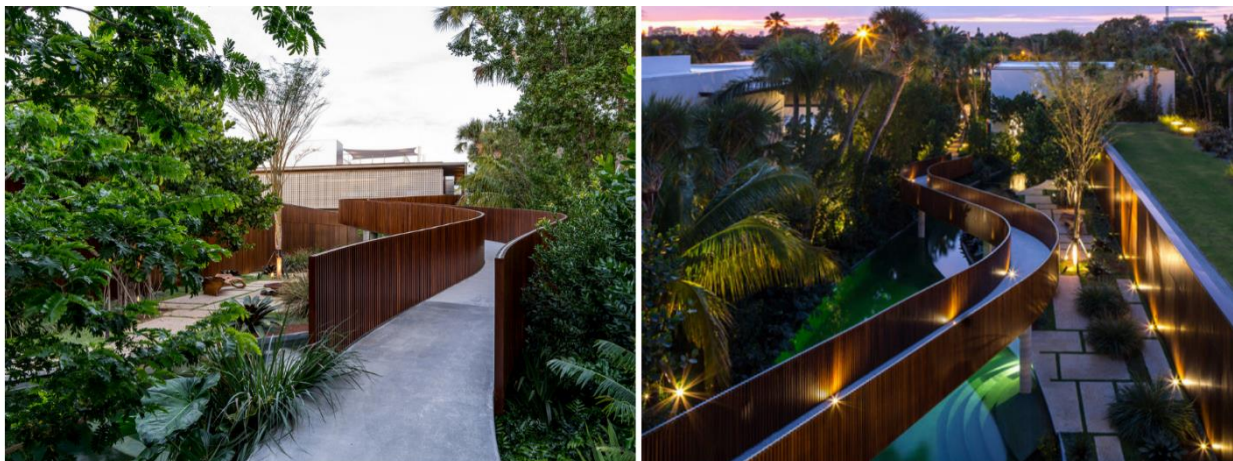
Figura 34: Rampa de acesso ao pavimento social
