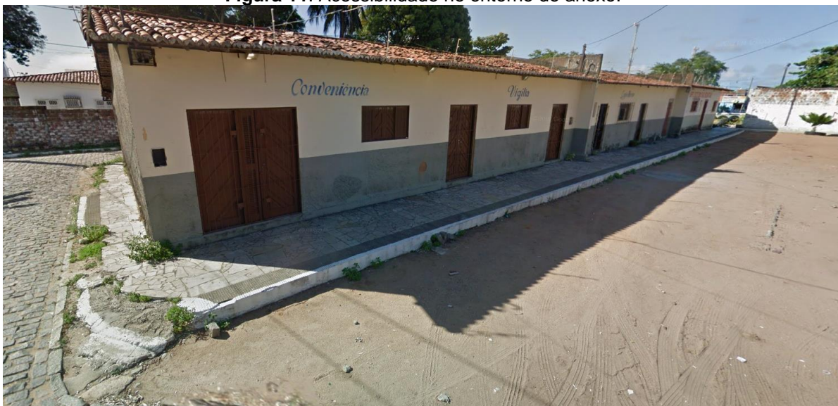
Figura 11: Acessibilidade no entorno do anexo.
