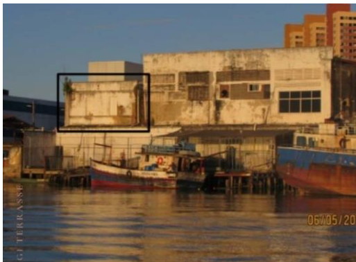
Figura 34 – Fotografia do local, fachada lateral
