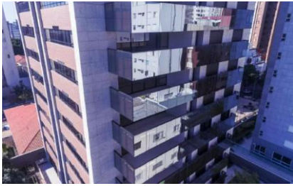
Figura 74 – Vidros com proteção solar
