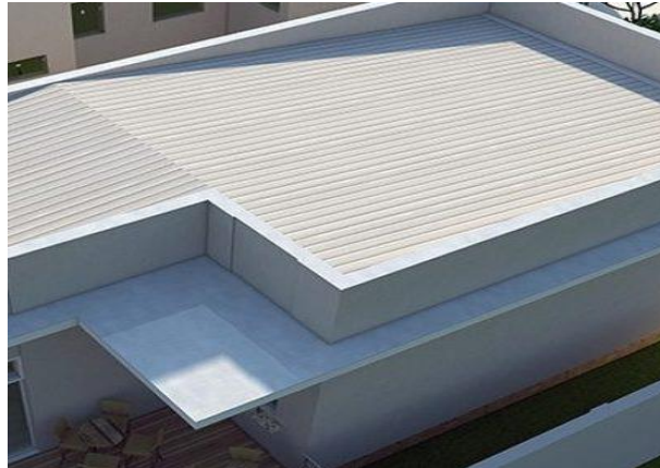
Figura 78 – Telha de fibrocimento
