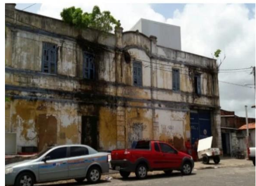
Figura 35 – Fotografia do local, fachada frontal
