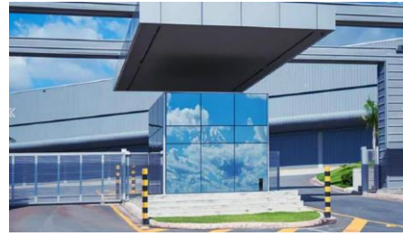
Figura 75 – Vidros com proteção solar
