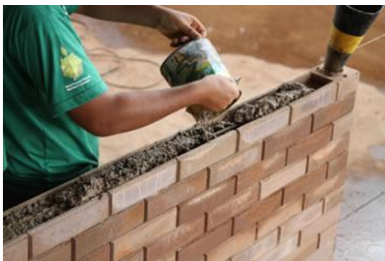
Figura 9 – Assentamento de um tijolo modular canaleta.
