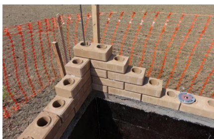
Figura 8 – Assentamento da alvenaria e de ferros verticais.
