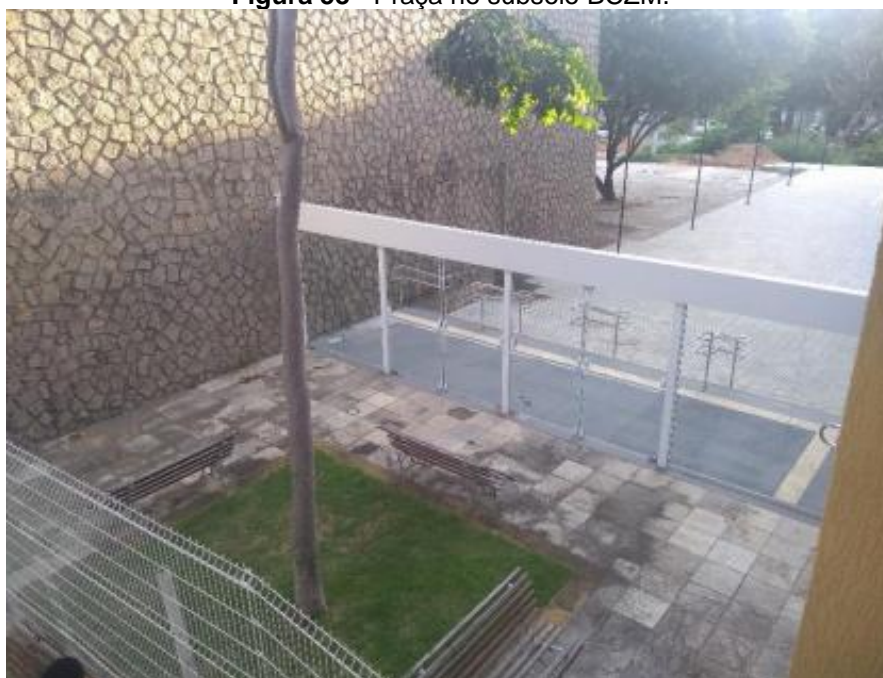
Figura 58 - Praça no subsolo BCZM.
