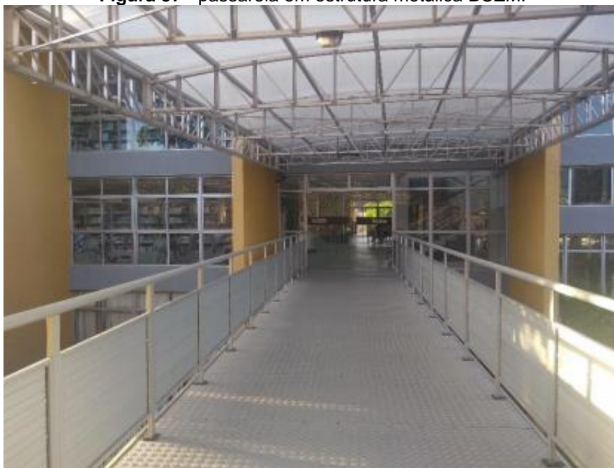
Figura 57 - passarela em estrutura metálica BCZM.
