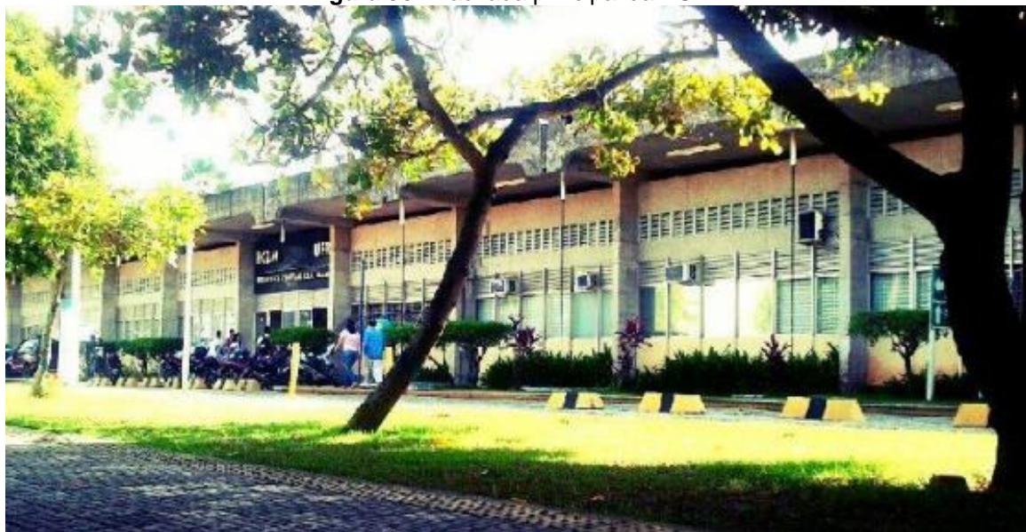
Figura 56 - Fachada principal da BCZM.
