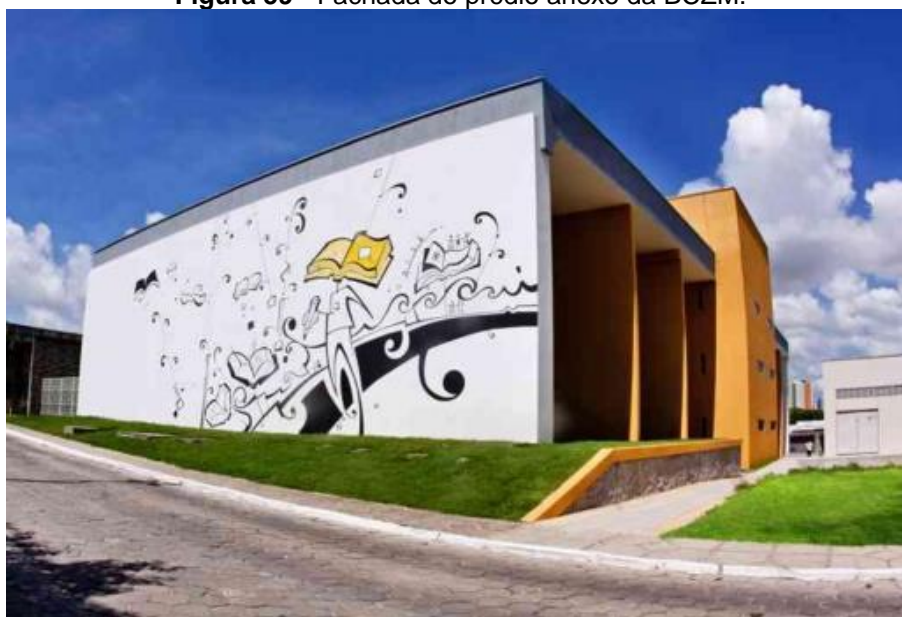
Figura 59 - Fachada do prédio anexo da BCZM.
