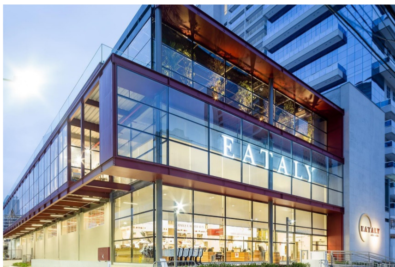
Figura 15- Perspectiva da fachada frontal Eataly São Paulo.
