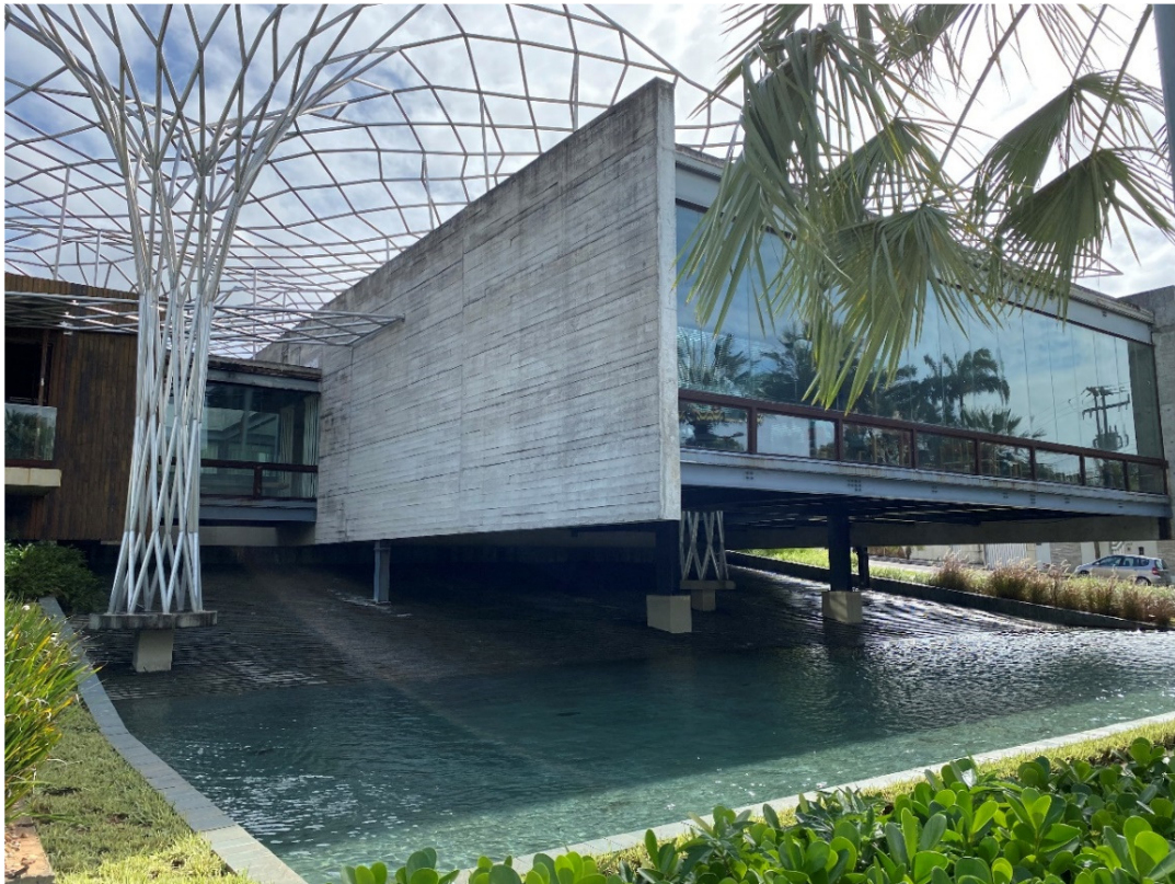
Figura 11- Malha metálica e Espelho D'água.
