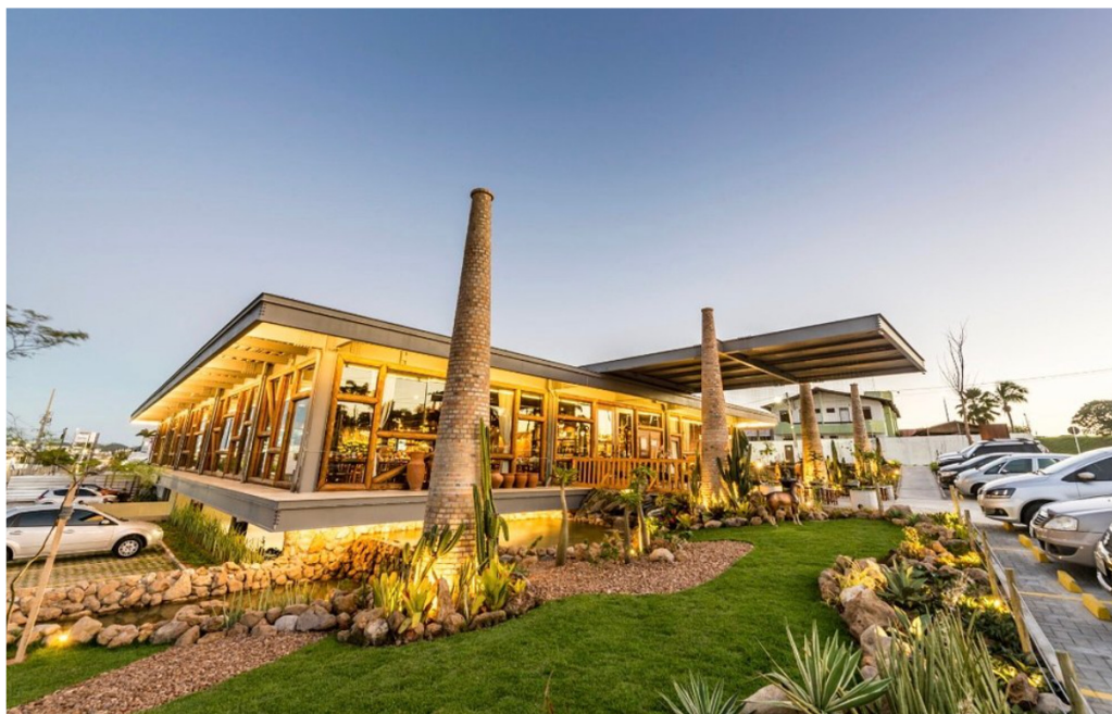
Figura 6- Restaurante Mangai de Ponta Negra
