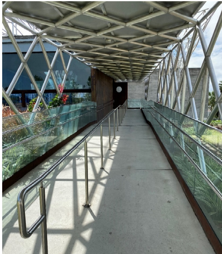
Figura 14- Rampa de acesso com cobertura metálica.
