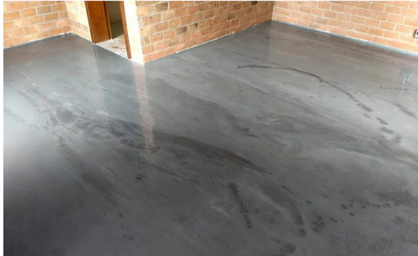
Figura 73- Piso Epóxi cor cimento queimado fosco
