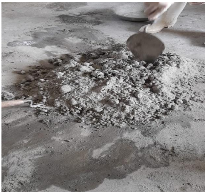
Figura 4: Preparação da argamassa
