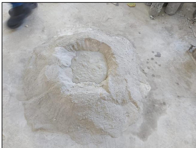
Figura 35 – Adição de água
