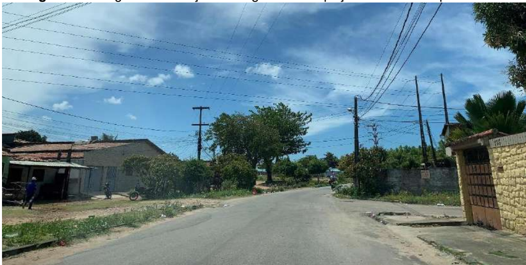
Figura 76 - Registro 07: Calçadas irregulares e espaços urbanos comprometido.
