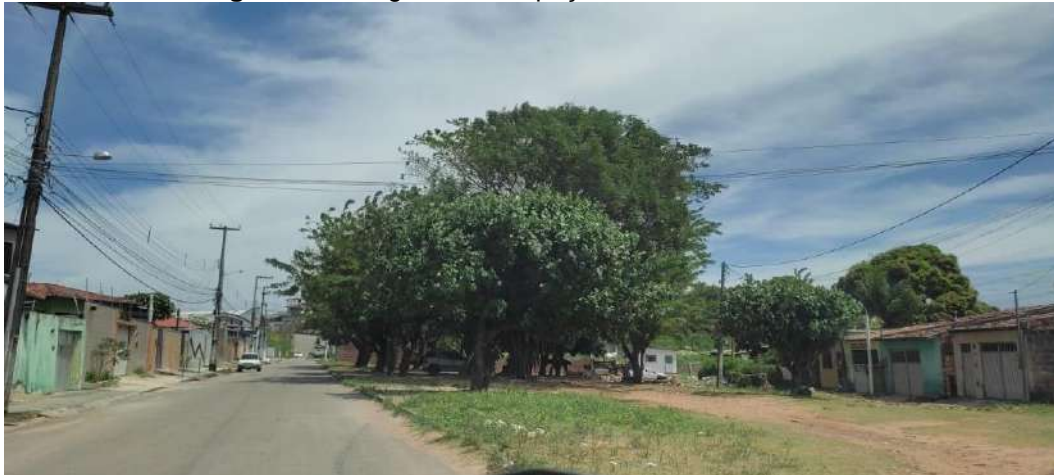
Figura 75 – Registro 06: Espaços verdes deteriorados.
