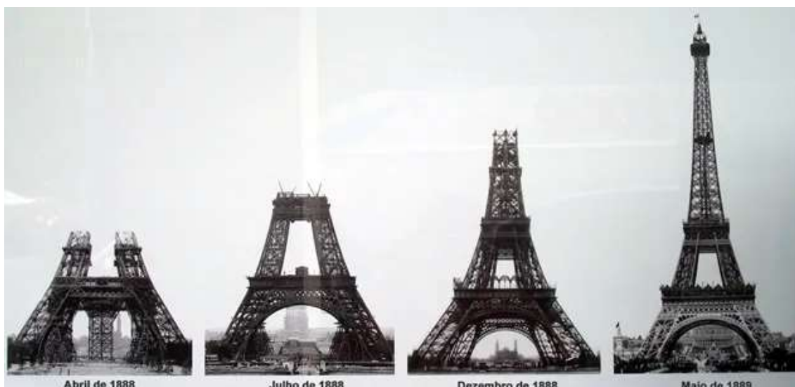
Figura 3 - Processo de montagem da Torre Eiffel
