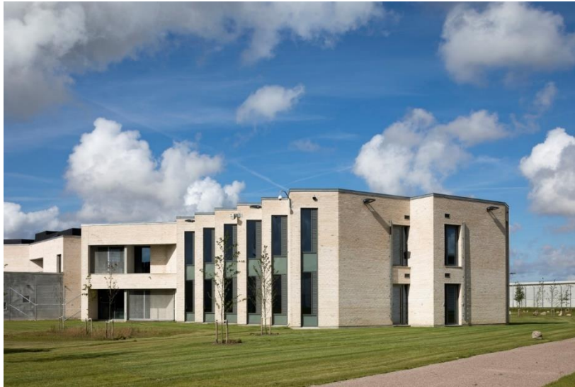
Figura 2 - Fachada da Prisão Storstrom
