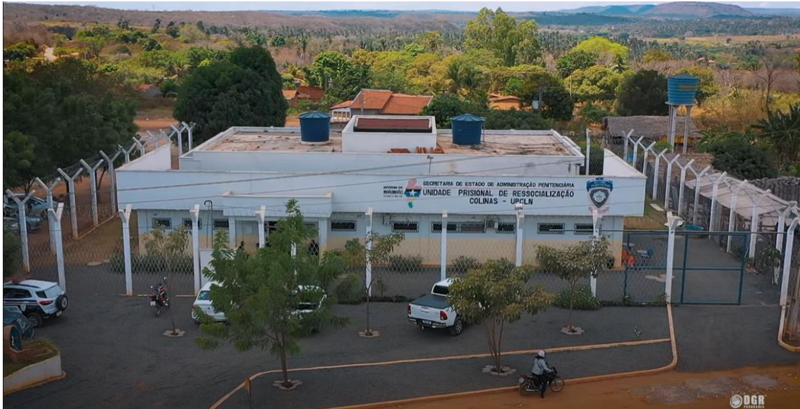
Figura 12 - Vista aérea da UPR Colinas
