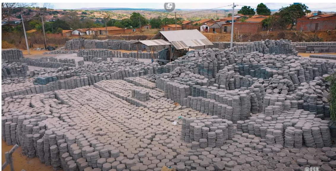
Figura 13 - Fábrica de blocos de concreto na UPR Colinas
