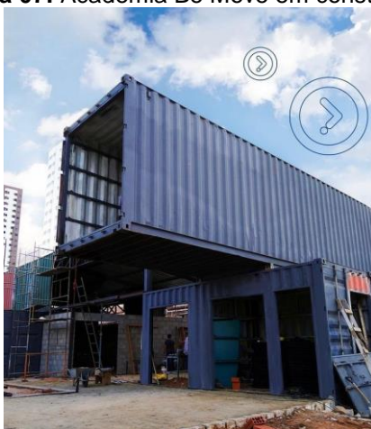
Figura 07: Academia Be Move em construção.
