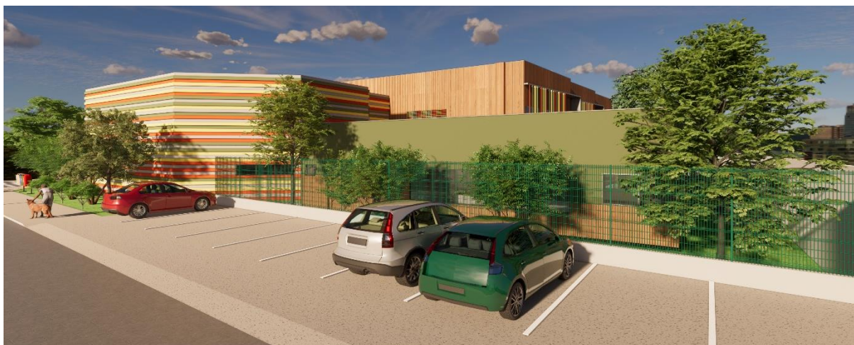
Figura 83 — Fachada lateral: Vagas para estacionamento
