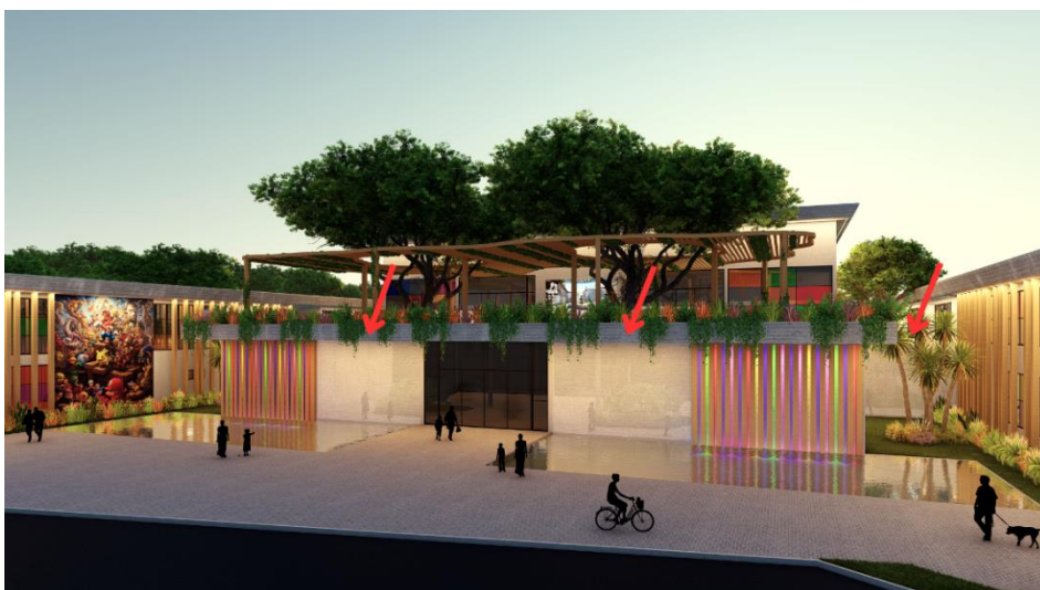
Figura 83 - Concreto translúcido aplicado no Complexo
