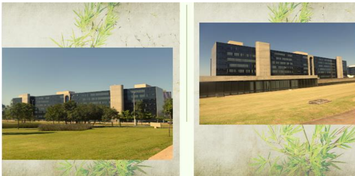
Figura 15: Fachada frontal do edifício anexo – TST – Brasília.
