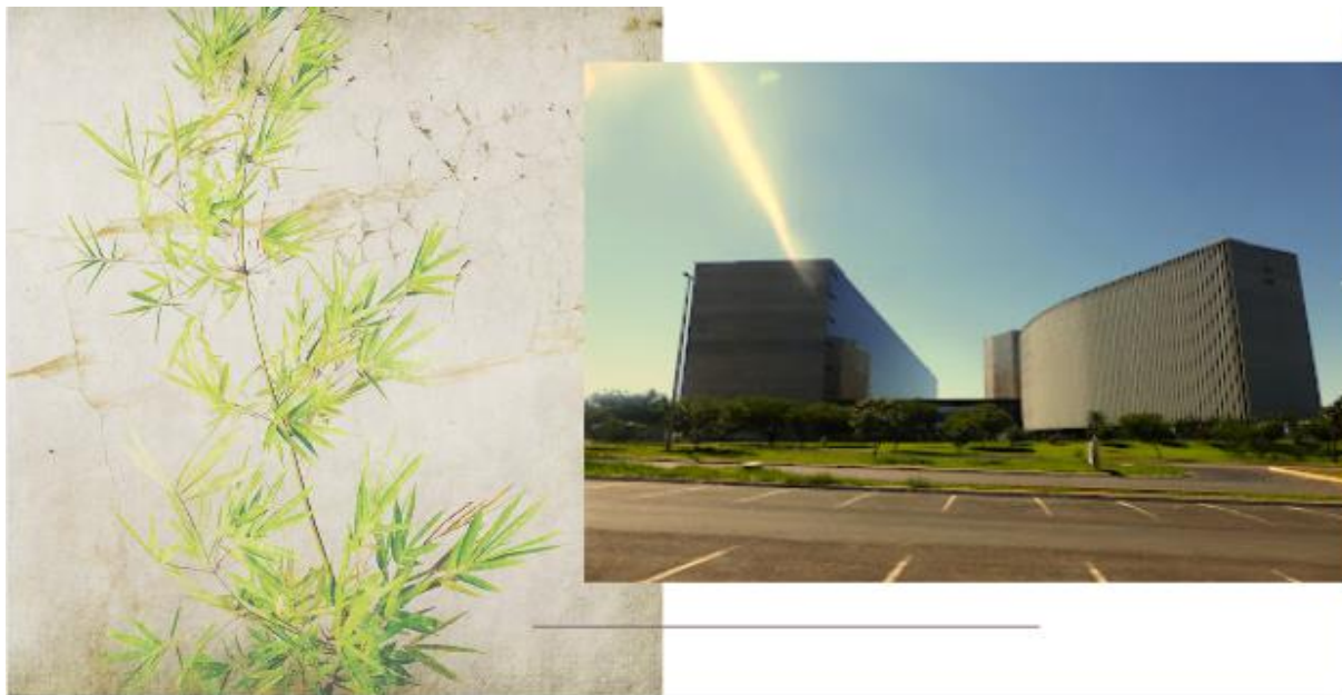
Figura 13: Vista lateral esquerda da fachada frontal do Edifício Principal, caracterizado por sua arquitetura curva – TST – Brasília.
