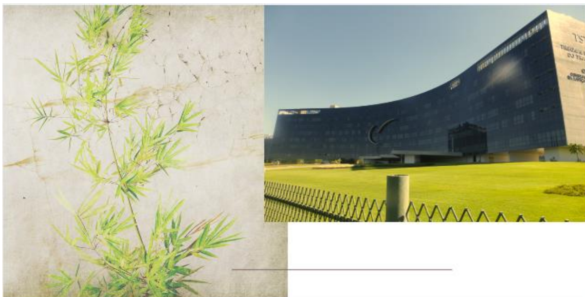
Figura 09: Frente do edifício principal – TST- Brasília.
