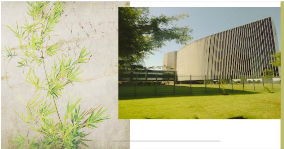
Figura 14: Fachada posterior do edifício principal – TST – Brasília.
