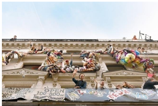
Figura 5 - Fachada frontal da galeria 59 Rivoli
