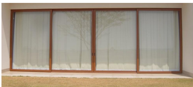
Imagem 74 – Porta de correr, 4 folhas, de PVC amadeirado e vidro.
