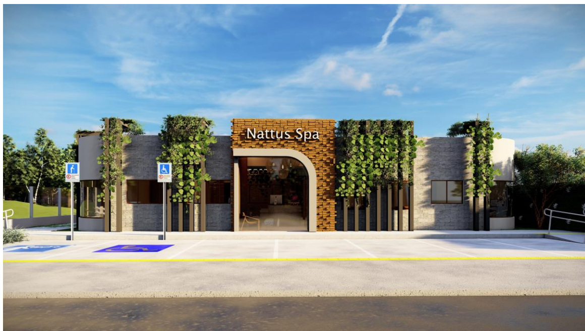
Imagem 79 – Fachada Sudeste (Fachada principal – Rua Virginópolis).
