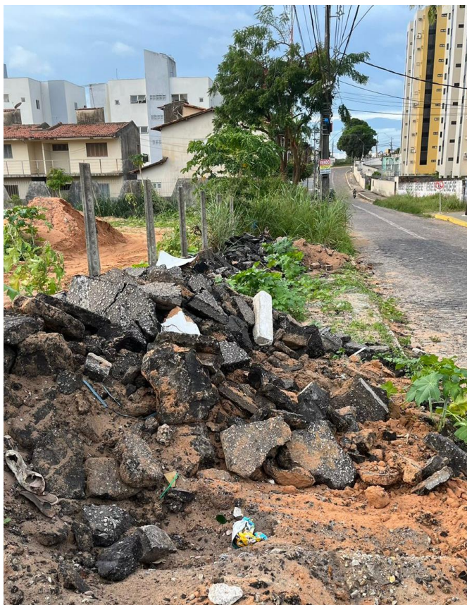
Imagem 36 – Imagem do lote para intervenção – área destinada a calçada.
