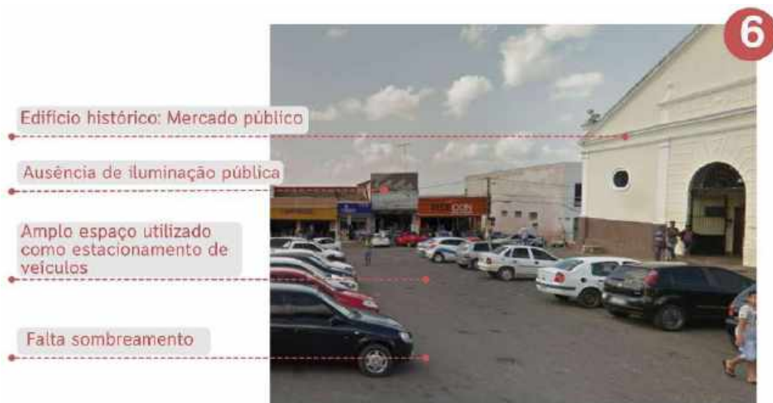
Figura 34: Problemas encontrados no entorno do Mercado Público.
