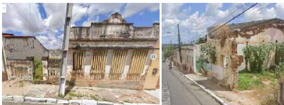
Figura 50 e 51: Residência em processo de degradação na seção 02.
