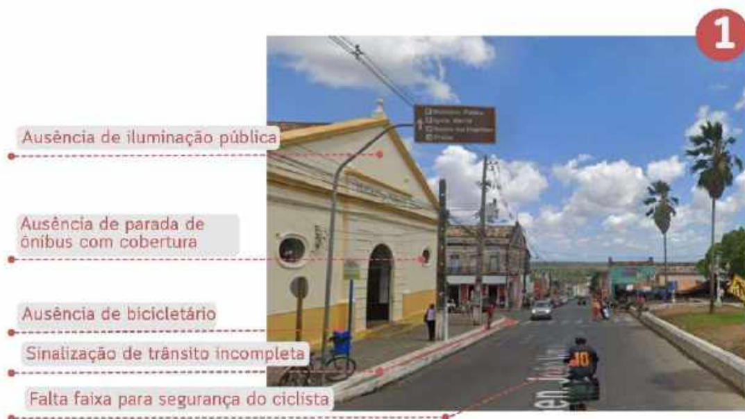
Figura 29: Problemas encontrados na via General João Varela.
