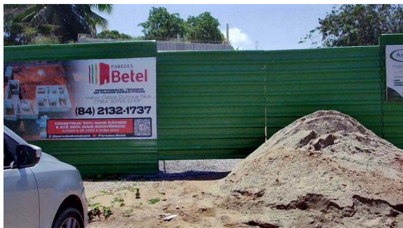
Figura 67: Sinalização do canteiro de obras.
