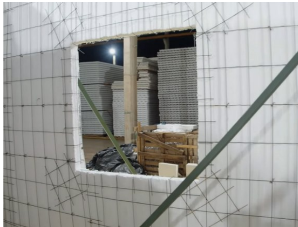
Figura 26: reforços instalados em uma abertura de janela.
