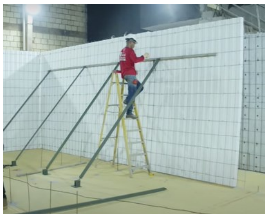
Figura 36: Escoras travadas no contrapiso.
