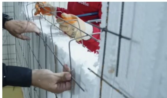
Figura 27: Instalação de reforço U.
