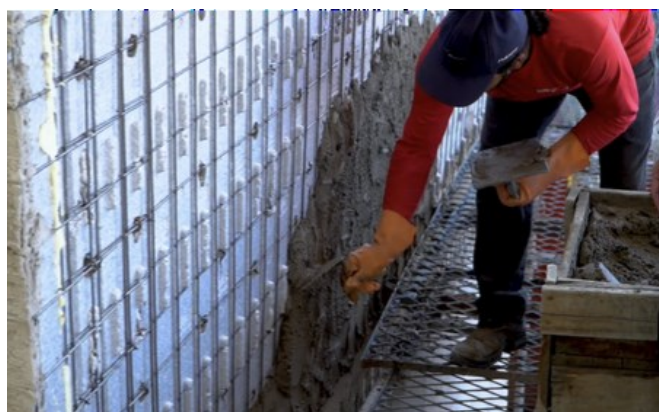
Figura 39: Confeção da argamassa armada.
