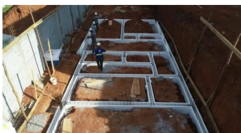
Figura 12: Utilização de canaletas em EPS.
