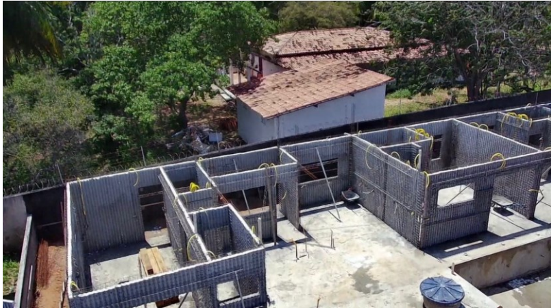
Figura 65: Imagem aérea da execução das paredes do piso térreo.
