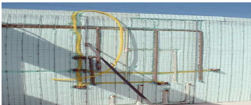
Figura 3: Painéis EPS com cavidades para instalação de materiais elétricos.
