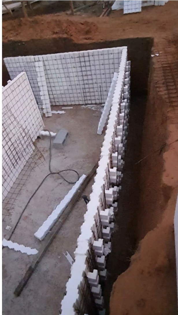
Figura 74: Vista superior execução piscina.
