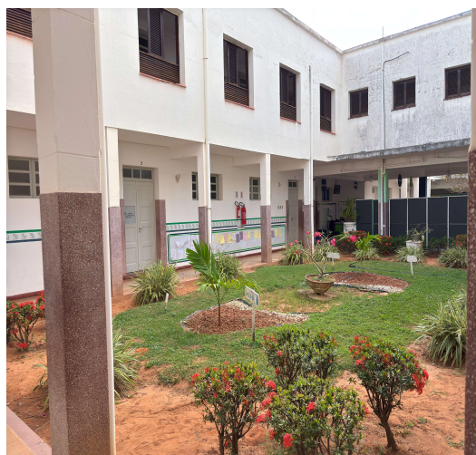
Figura 3 – Área interna do setor I
