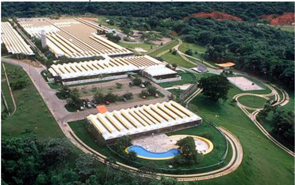
Figura 2: Exemplo de um projeto arquitetônico do tipo pavilhonar – vista aérea do Hospital Sarah Kubitschek, em Salvador
