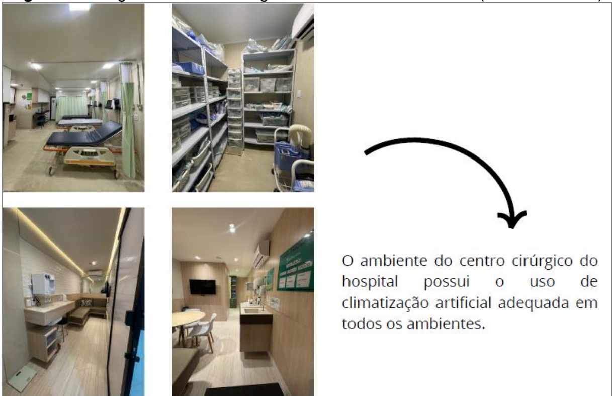
Figura 22: Imagens do centro cirúrgico – ambientes climatizados (ar condicionado)
