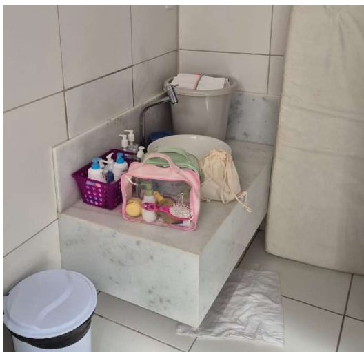
Figura 16 - Detalhe de pia rebaixada para criança
