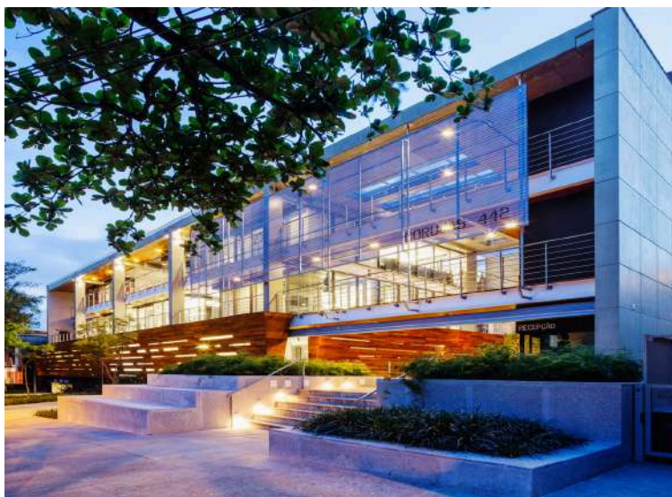
Figura 8 – Fachada do Edifício Corujas
