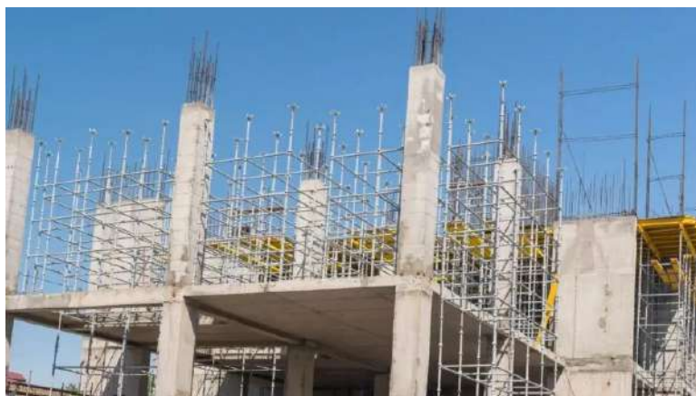
Figura 2 – Exemplo de Execução de Estrutura em Concreto
