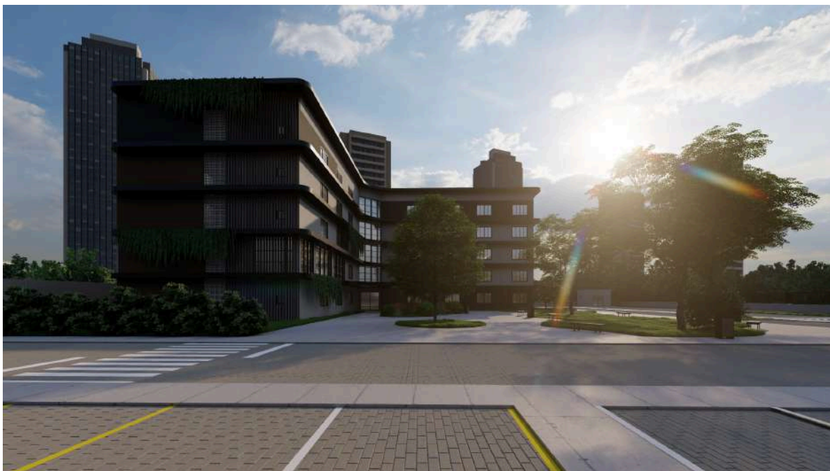
Figura 40 – Fachada lateral esquerda
