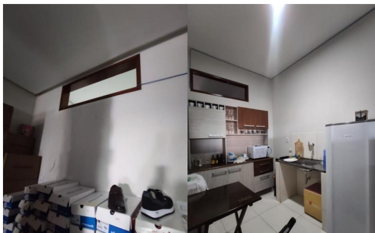
Figura 12 - Abertura lateral de ventilação entre o depósito e a cozinha
