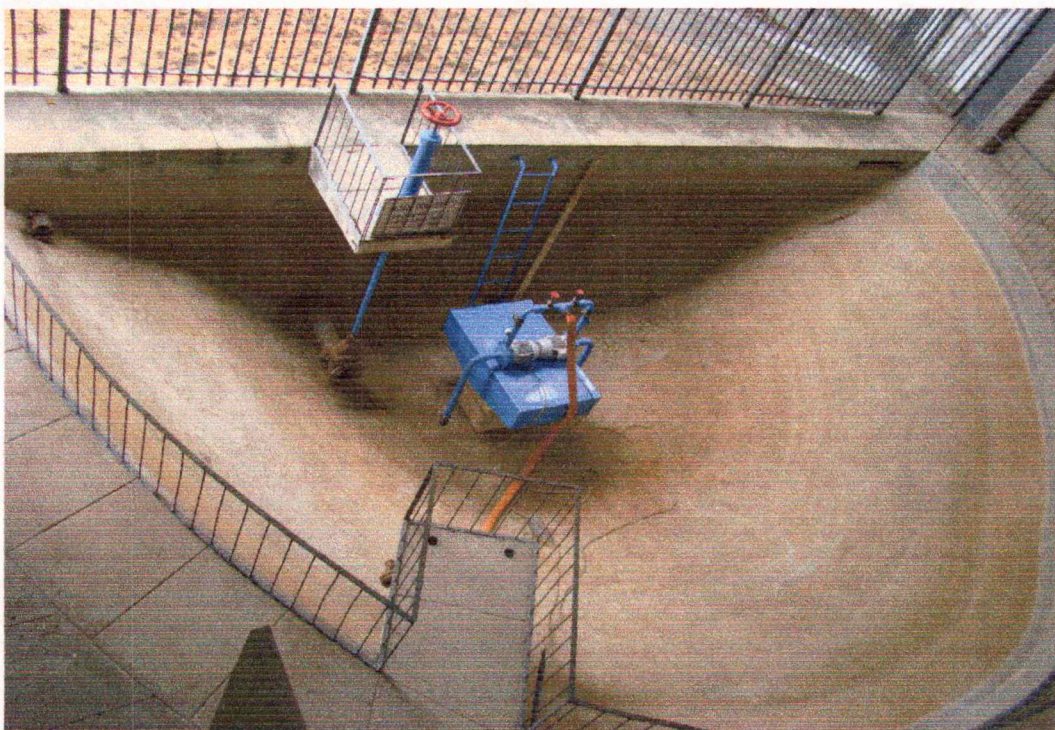
Figura 6 –Lagoa de captação da estação Saturnino de Brito
