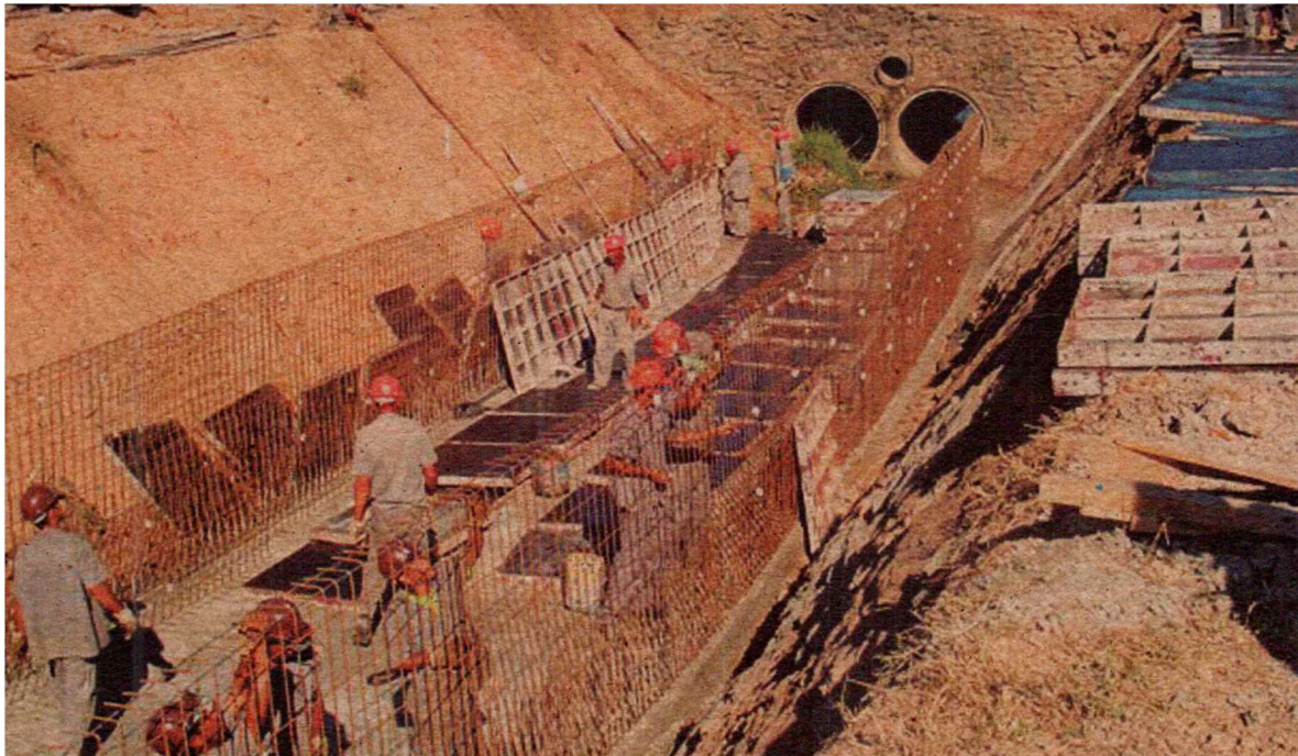
Obra de saneamento Bom Despacho – MG.
