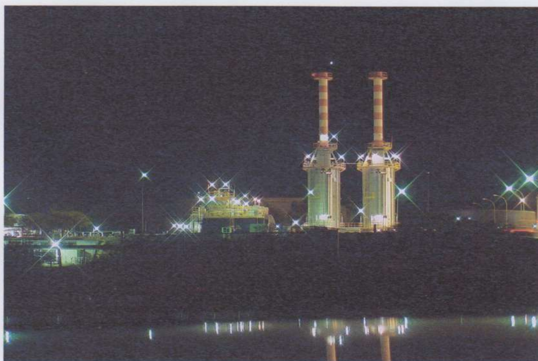
ANEXO B – Pólo industrial de Guamaré
