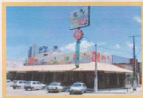
Figura 3: Matriz do Pittsburg, localizada Av. Prudente de Moraes. Fonte: Pittsburg (2006)
