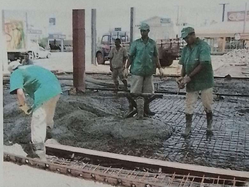
Figura 4 – Colocação de piso em concreto usinado.
