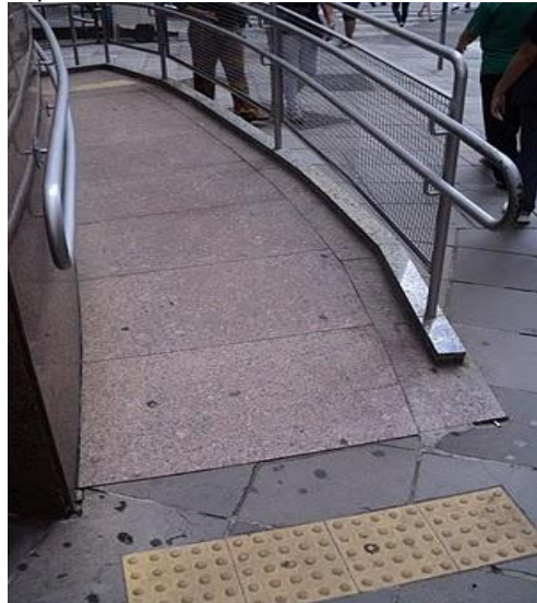
Figura 7 – Rampa com sinalização de piso tátil e corrimão
