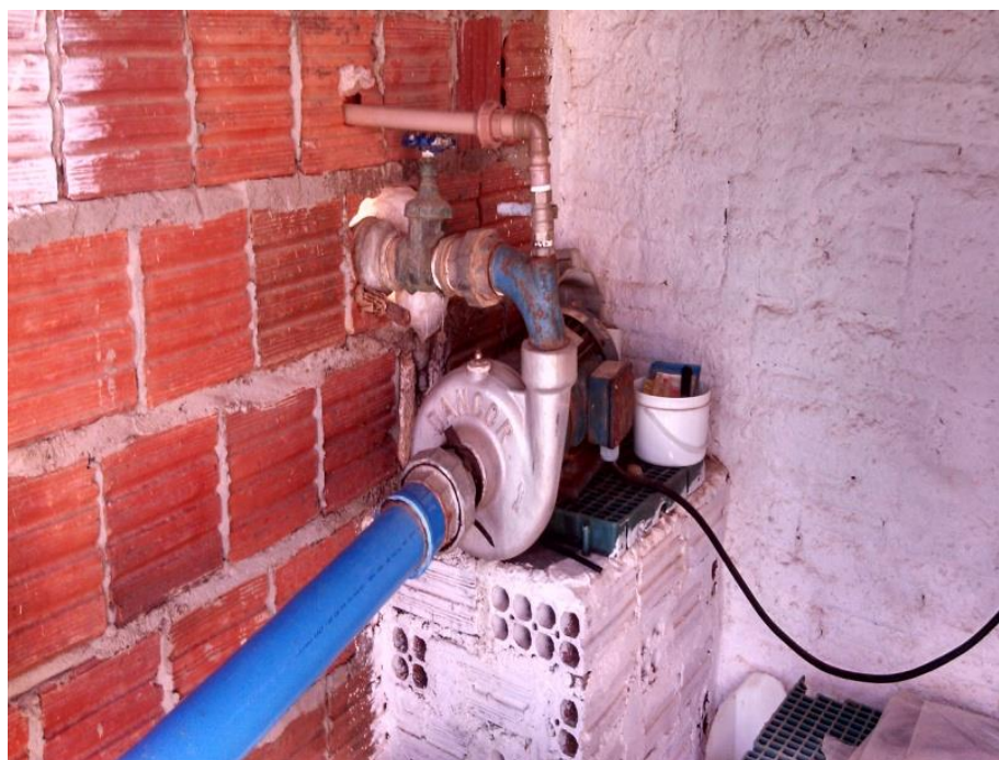
Figura 5 - Bomba de soda cáustica.
