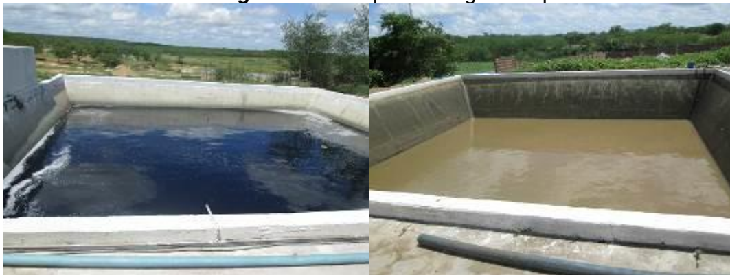
Figura 12. Tanques de Água Limpa
