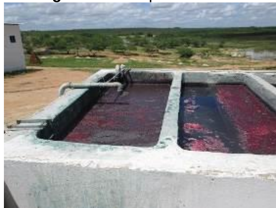
Figura 10. Tanque Floculador
